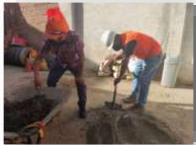
Preparación de la mezcla de concreto
