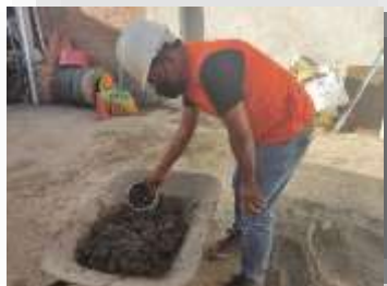
Adición de molidos de carcasas de plástico a la mezcla de concreto
