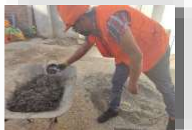
Adición de molidos de carcasas de plástico a la mezcla de concreto
