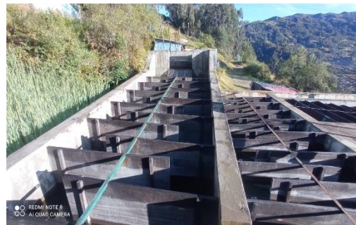
Foto 4: Estructura existente de coagulación y floculación, en la cual se incluirá el coagulante químico sulfato de aluminio.
