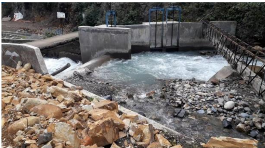
Foto 7: Bocatoma del agua en el Rio Pomabamba
