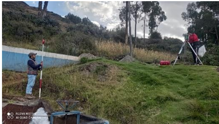
Foto 2: Topografía para graficar las estructuras existentes de la planta de tratamiento de agua potable.
