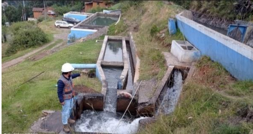
Foto 1: Desarenador existente.
