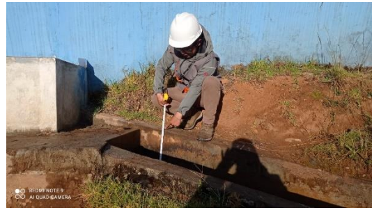
Foto 9: Medida de la altura del canal
