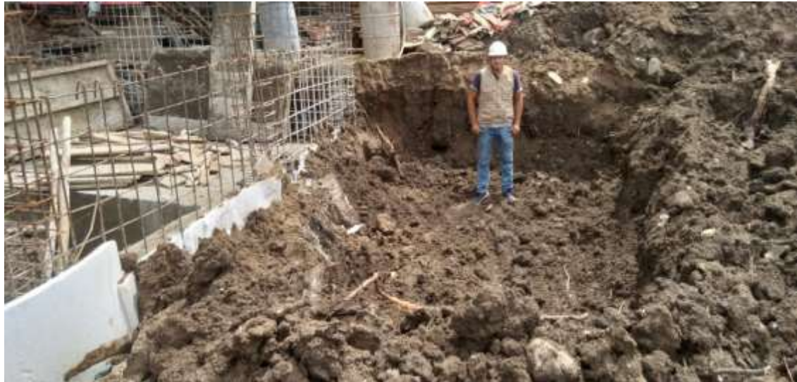
IMAGEN 02: Se empieza a sacar la muestra del estrato del suelo
