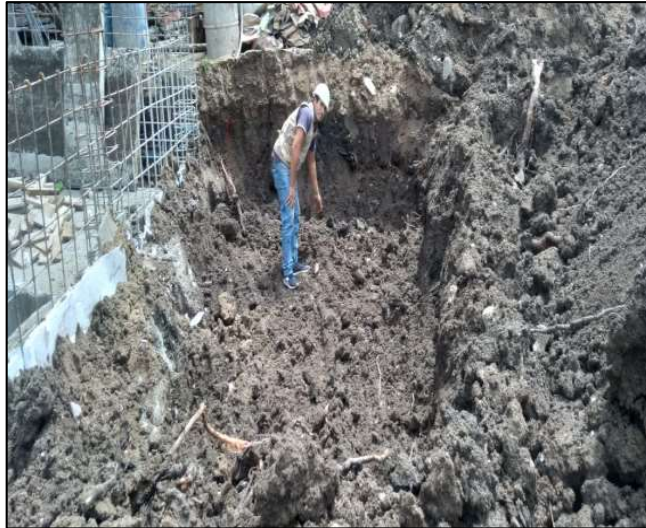
Figura 1 Verificación de calicata
