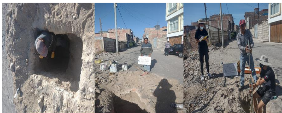
Excavación de la calicata 2 y ensayo de DLP
