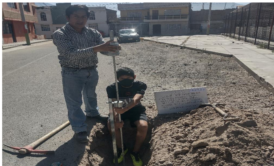
Figura 16: Ensayo del DPL en la calicata C- 1
