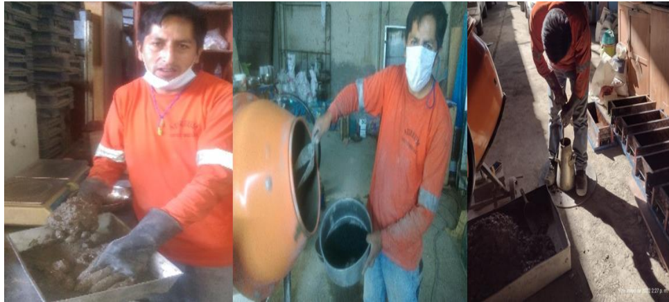
Verificación de la dosificación para 500g de cemento
