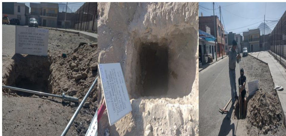
Excavación de la calicata 1 y ensayo de DLP
