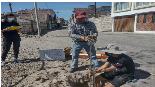
Figura 13: Ejecución de ensayo DPL en la Calicata C-2
