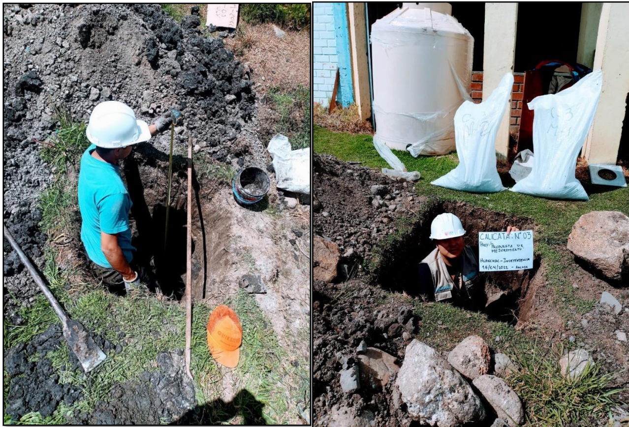
Imagen N° 3: Excavación de las calicatas para posterior a ello analizarlas.
