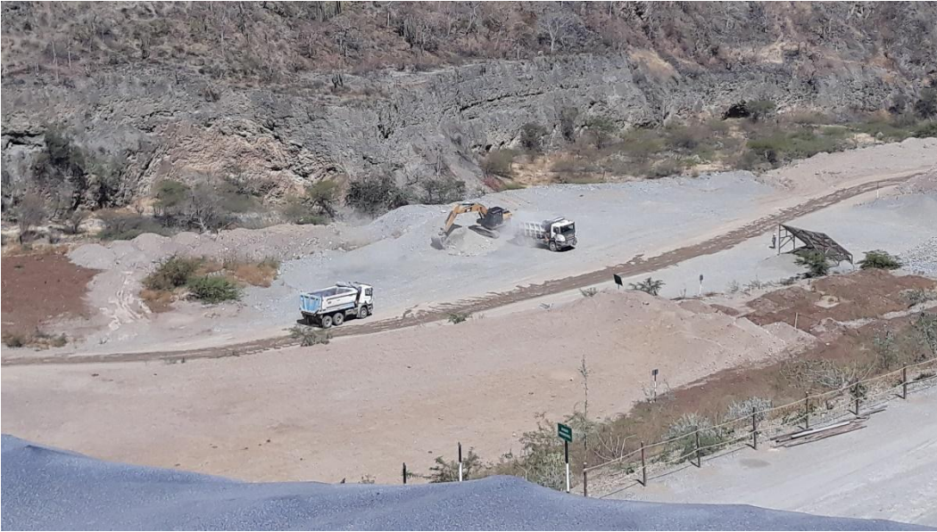
Figura 27: maquinaria pesada operativo en relave minero.
