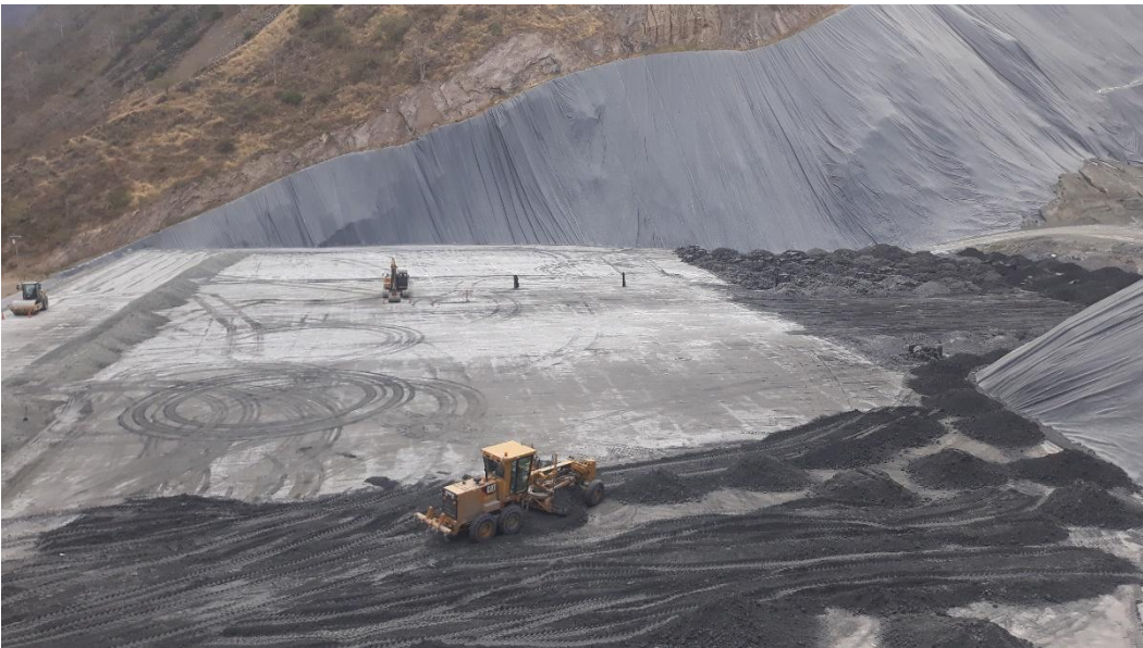
Figura 26: maquinaria pesada operativo en relave minero.
