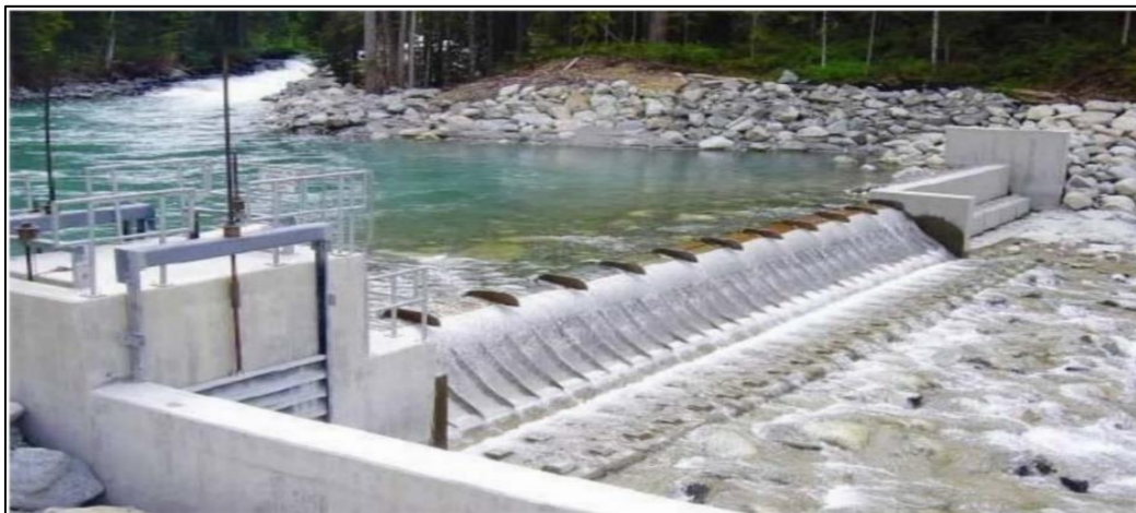
Figura 3: Captación de agua superficial.
