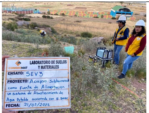
Figura 12: Sondaje eléctrico vertical (SEV 3) tendido de cable para la obtención de datos
