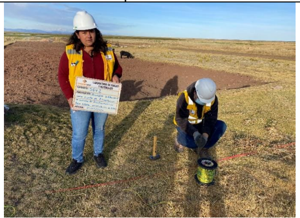
Figura 10: Sondaje eléctrico vertical (SEV 2) tendido de cable para la obtención de datos
