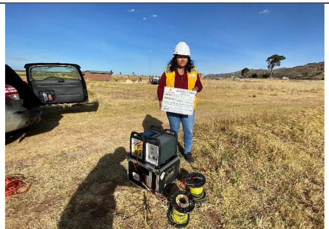
Figura 6: Equipo completo para realizar el sondaje eléctrico vertical.
