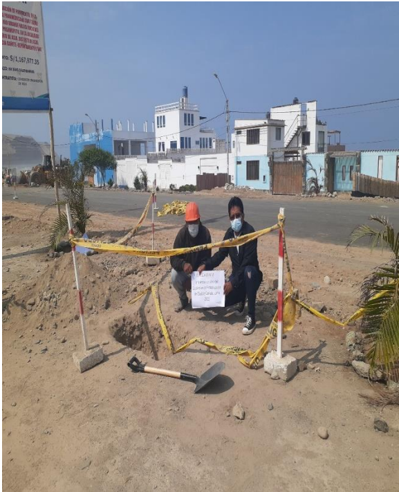
Excavación a 1.50 mts de profundidad de calicata N°01
