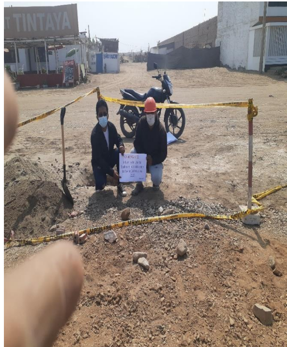
Excavación a 1.50 mts de profundidad de calicata N°02
