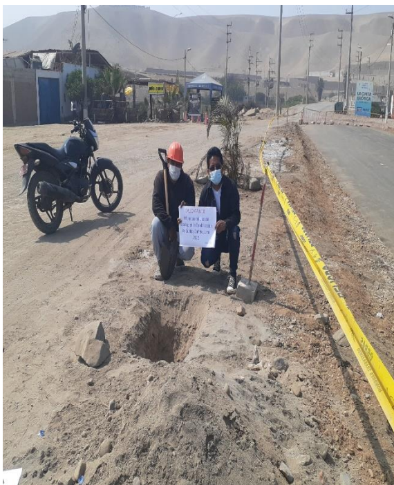
Excavación a 1.50 mts de profundidad de calicata N°03.
