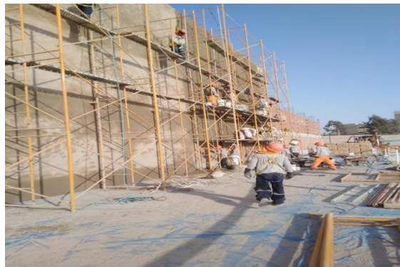
Figura 7: Construcción de edificaciones
