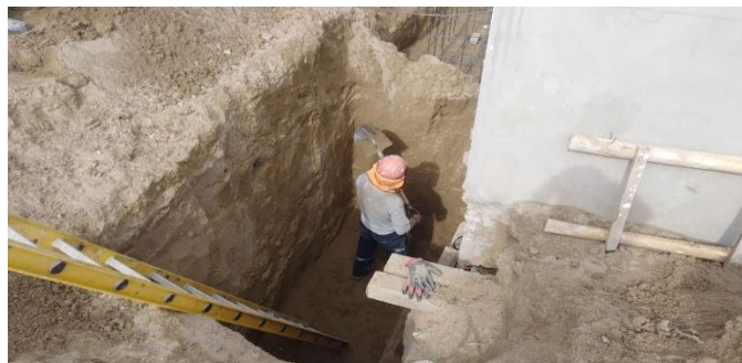
Figura 8: Movimiento de tierra
