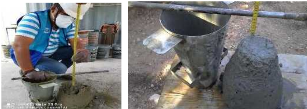
Figura N° 10 Asentamiento de concreto por el método Slump.
