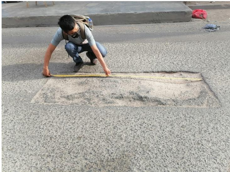
**Figura 4:** Falla del Pavimento, Hueco.
