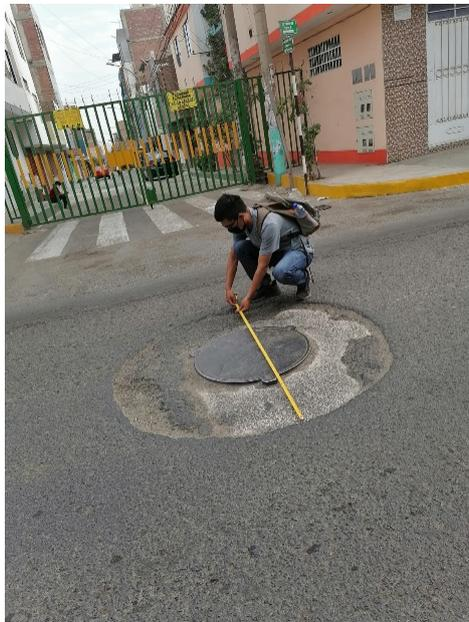
**Figura 6:** Falla del pavimento, Abultamientos.
