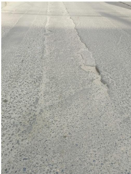
**Figura 9:** Falla del pavimento, Hundimientos.
