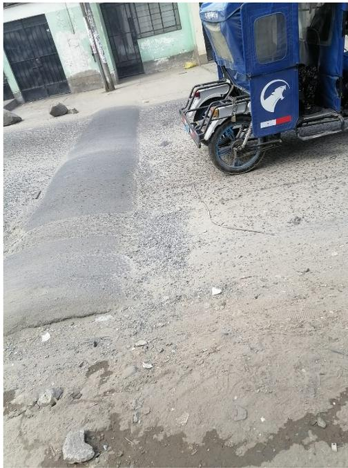
**Figura 8:** Falla del pavimento, Desprendimiento de agregados.
