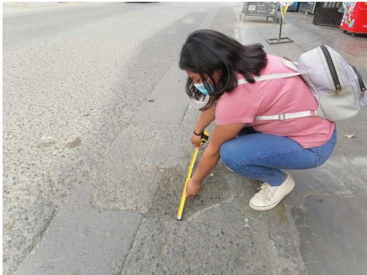
**Figura 7:** Falla del pavimento, Huecos.
