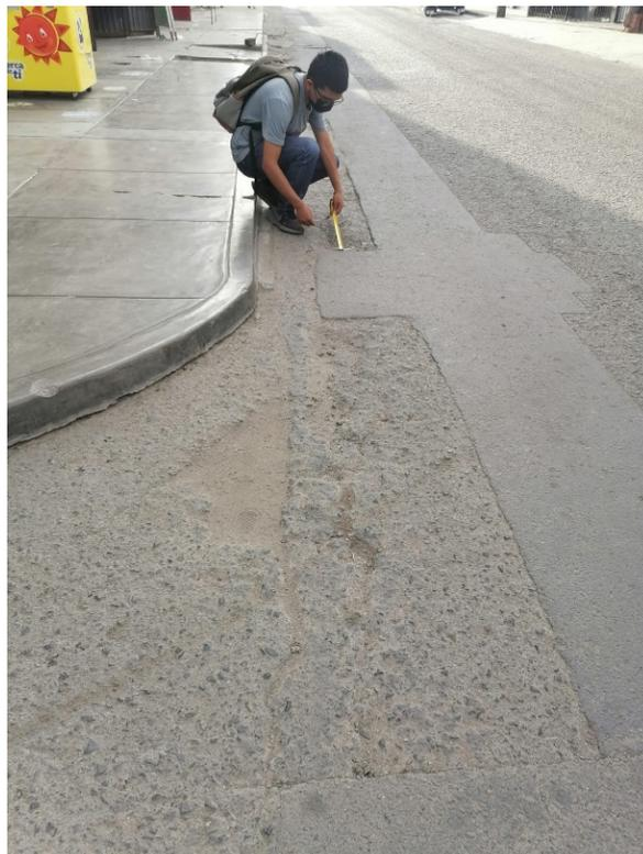
**Figura 5:** Falla del pavimento, Grieta de borde.
