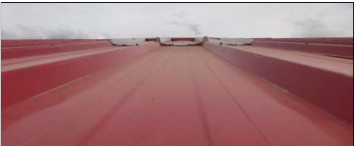
**Figura 54.** Se observa presencia de agujeros en las uniones de las calaminas
