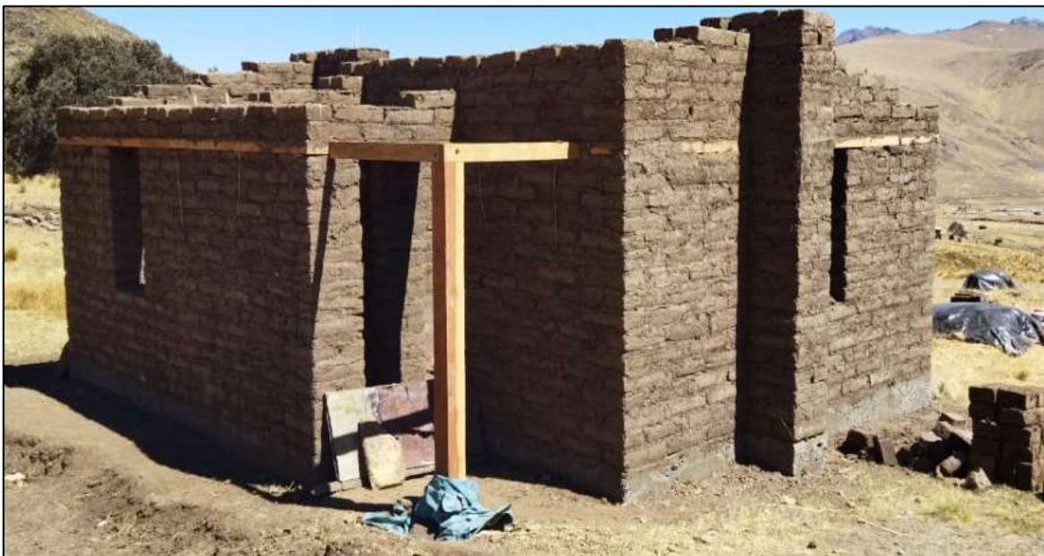
**Figura 7.** Muro de adobe, viga collar de madera y columna de madera.
