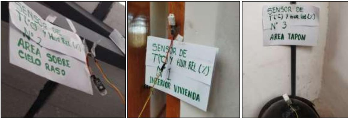
**Figura 70.** Ubicación de sensores de temperatura y humedad relativa.
