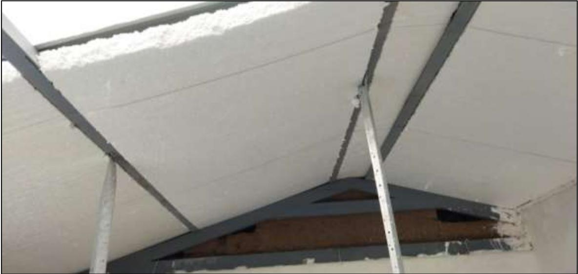
**Figura 52.** Se observa el poliestireno en el techo.
