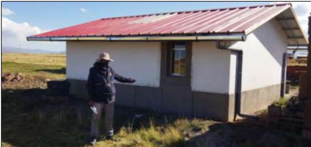
**Figura 9.** Cobertura, canal de drenaje, revestimiento con yeso, y ventanas.
