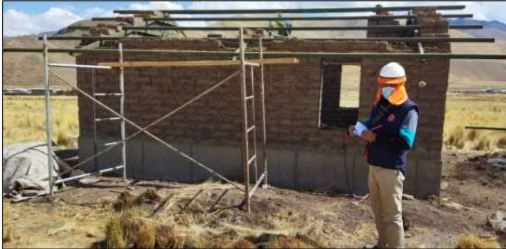
**Figura 8.** Tijerales, correa metálica y zócalo de cemento
