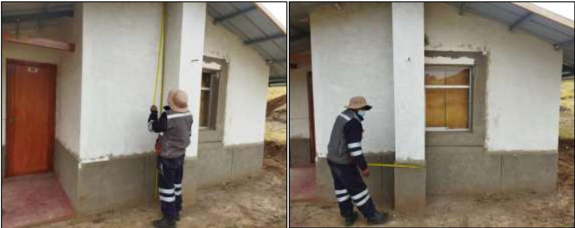
**Figura 48.** Medición con flexómetro la altura y ancho de la columna de adobe
