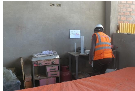
Fotografía 9. Se muestra la medición del agua para el mezclado del concreto.
