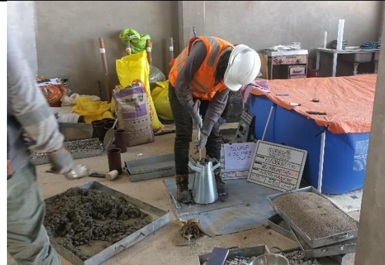
Fotografía 11. Se realizó el ensayo de slump o como de abrams.
