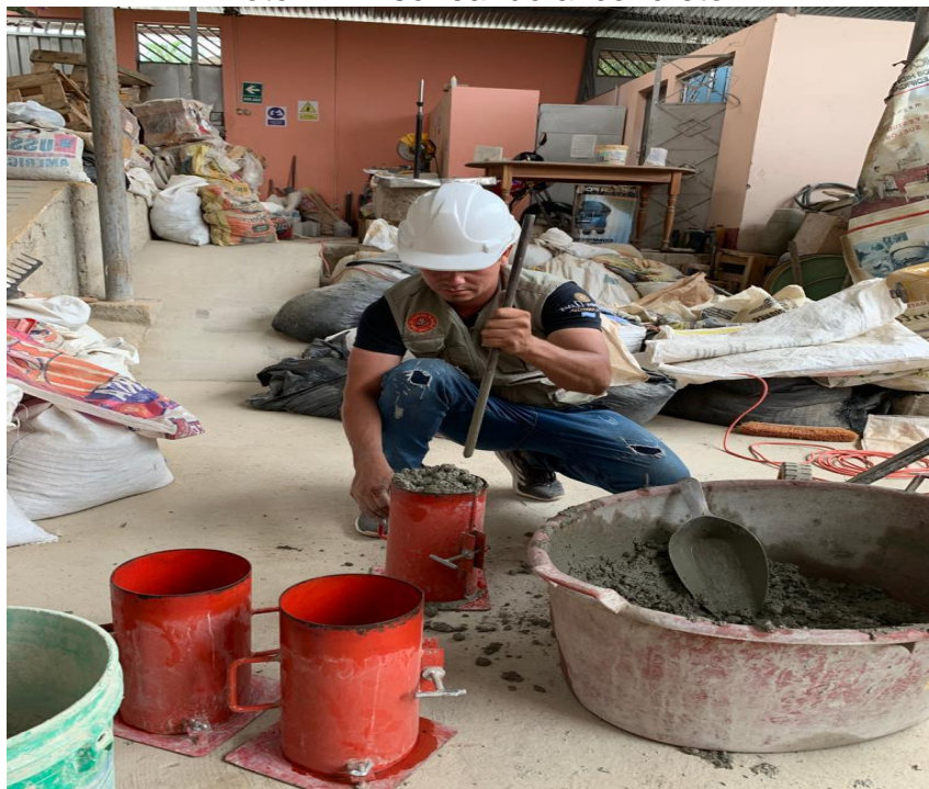
Foto 12. Pisoneando al concreto
