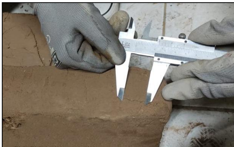
Figura 36: Cuantificación de fisuras adobe tipo1
