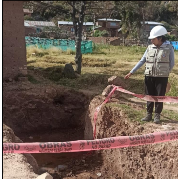
Figura 21: Calicata en terreno seleccionado
