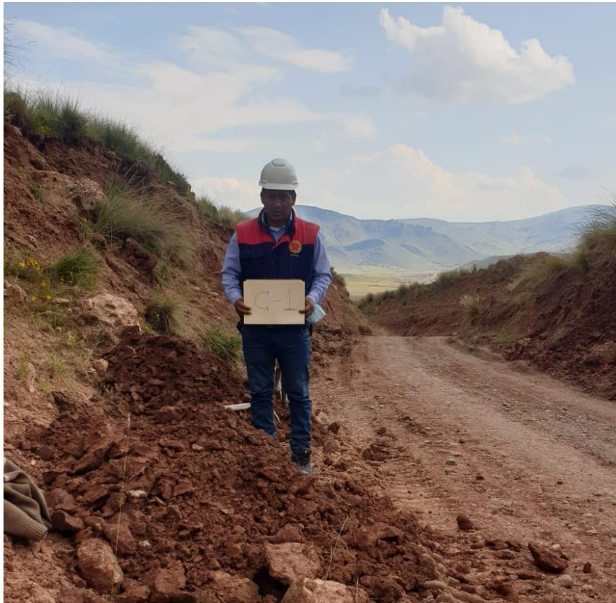
Descripción: Apertura de calicata C - 1
