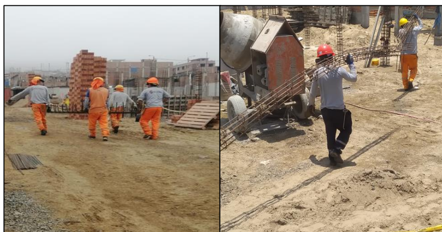
Figura 8. Transportes Innecesario de acero
