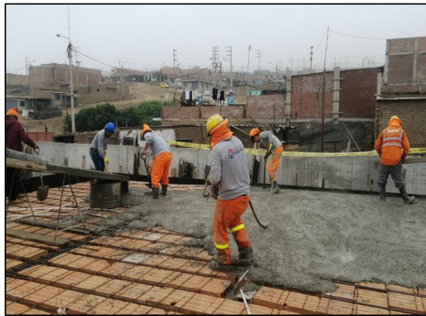
Figura 14. Vaciado de techo
