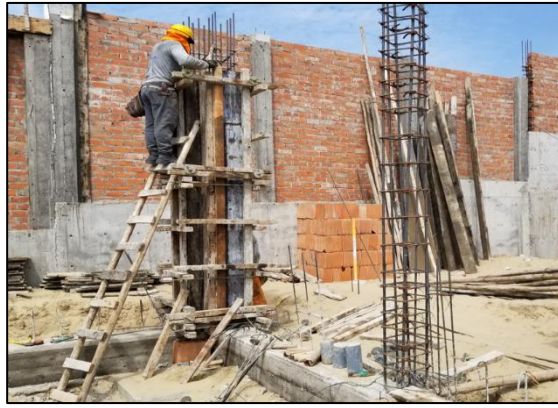
Figura 13. Encofrado de Columnas
