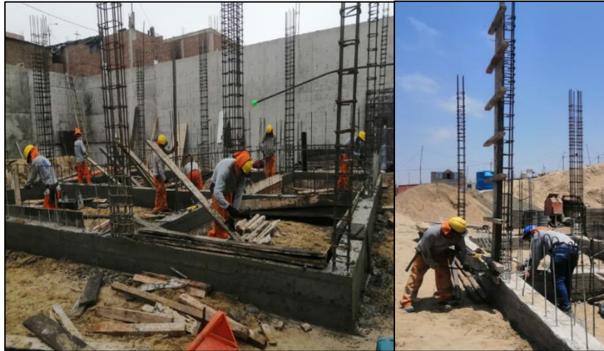
Figura 11. Falta de comunicación en Obra
