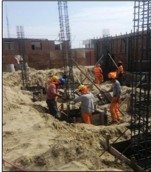
Figura 12. Habilitado de acero de Columnas
