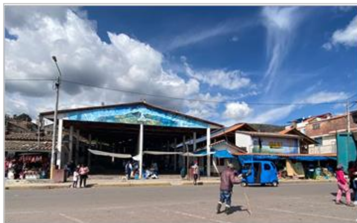
Figura 9: Acceso principal al centro gastronómico
