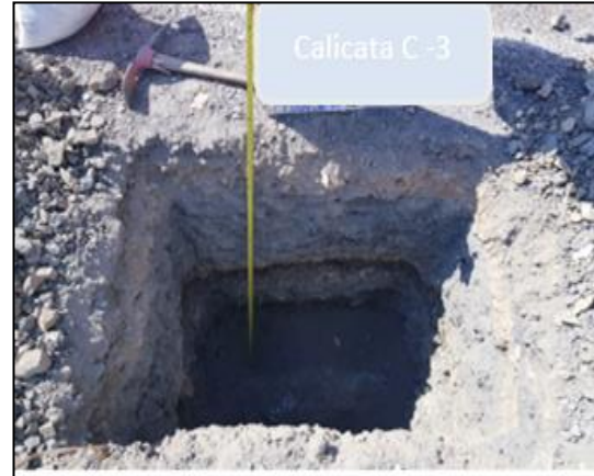
Foto 4: CALICATA C-3. DE LA CARRETERA PARCO VIÑAUYA
