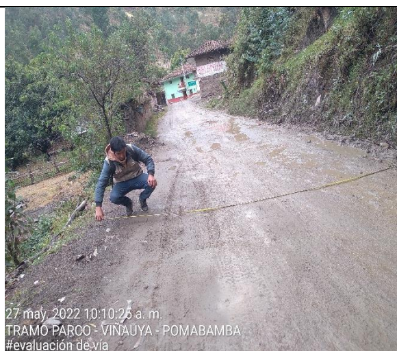
FOTO 3: VERIFICACIÓN DEL ANCHO DE LA VÍA
