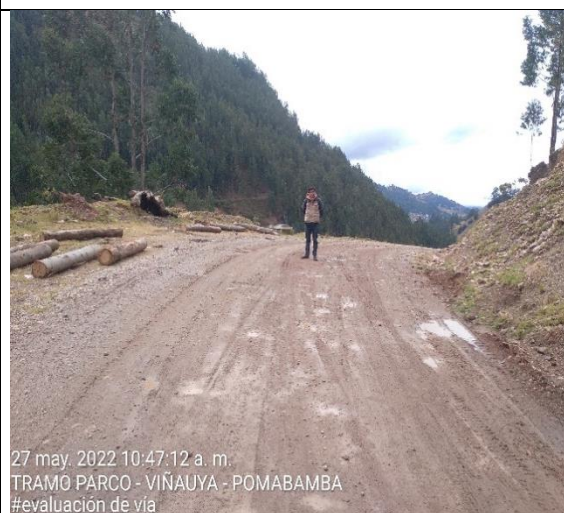
FOTO 4: INSPECCIÓN DE PLAZOLETAS DE PASE.
