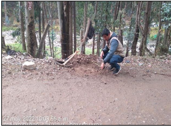
Foto 1: MEDICIÓN PARA CALICATA C-1. DE LA CARRETERA PARCO VIÑAUYA
