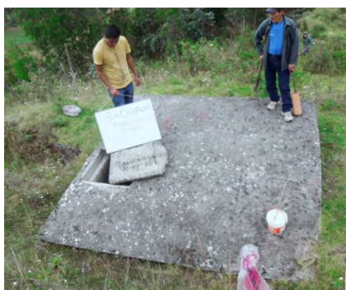
Figura 15. Estructura de reservorio existente construida en el año 1992
