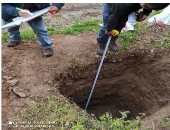
Figura 22. Excavación de Calicatas
