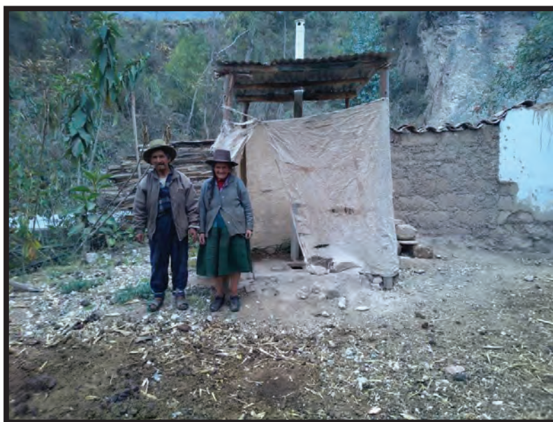
Foto N° 12: los servicios higiénicos se encuentran en un estado deterioro.
