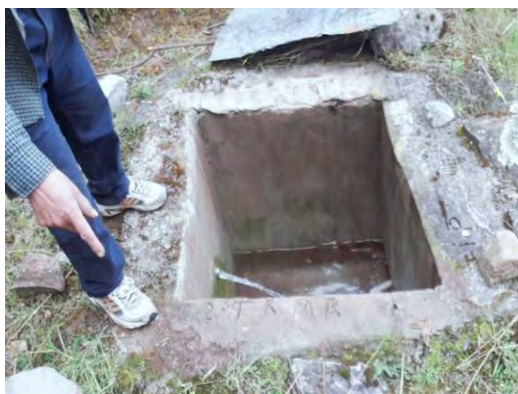
Figura 13. Infraestructura existente de Captación Wakapuquio
