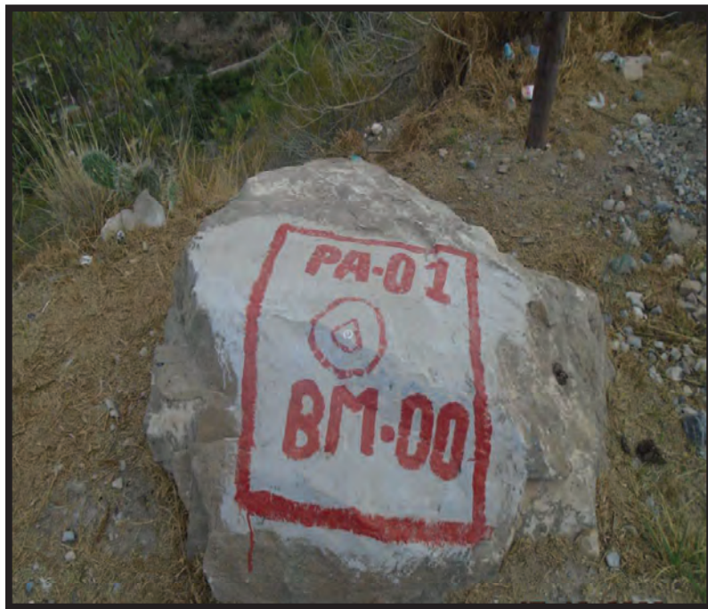
Foto N° 4: Pintado de los BMS durante el levantamiento topográfico.
