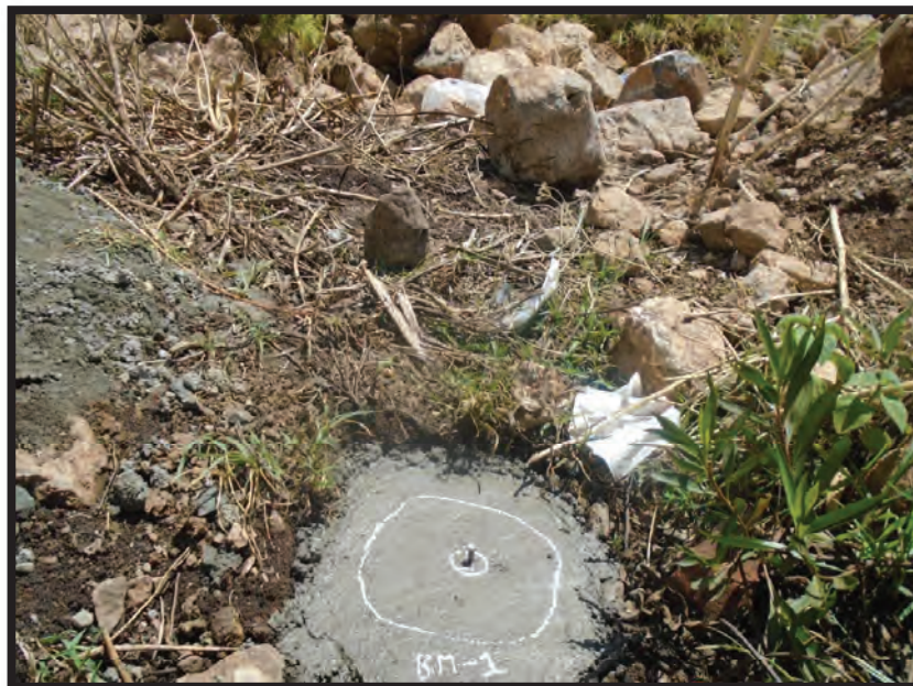
Foto N° 6: Pintado de los BMS durante el levantamiento topográfico.
