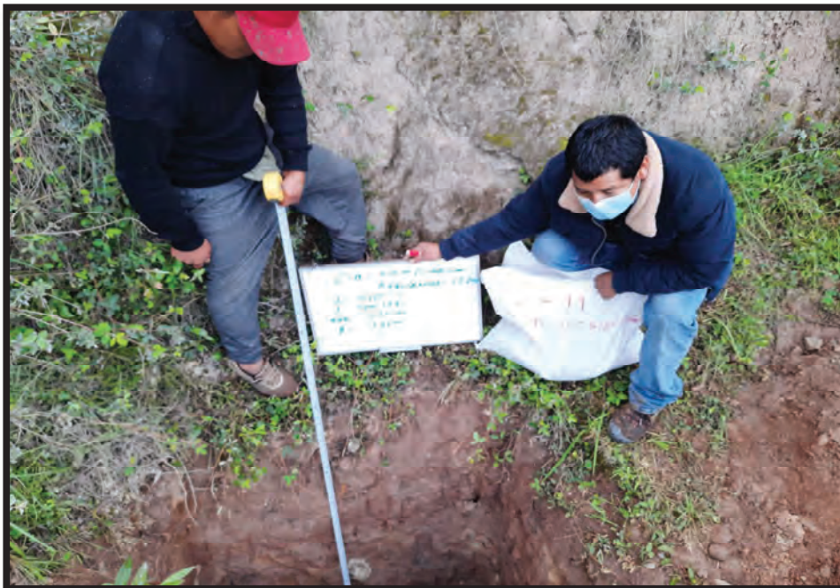
Foto N° 20: Calicata en Captación Sachapuna.
