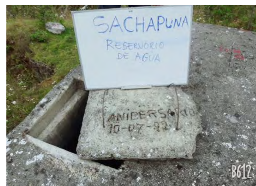
Figura 16. Estructura de reservorio existente construida en el año 1992
