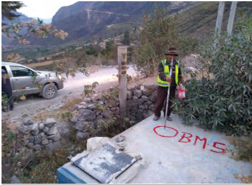
Foto N°3: pintado de los BMS - levantamiento topográfico
