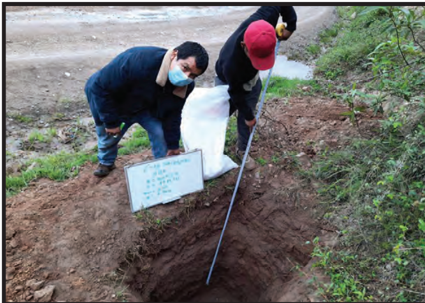
Foto N° 24: Sachapuna alta UBS – red de distribución de agua
