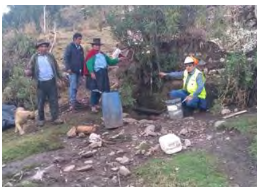
Figura 9. Estado de Piletas Existentes
