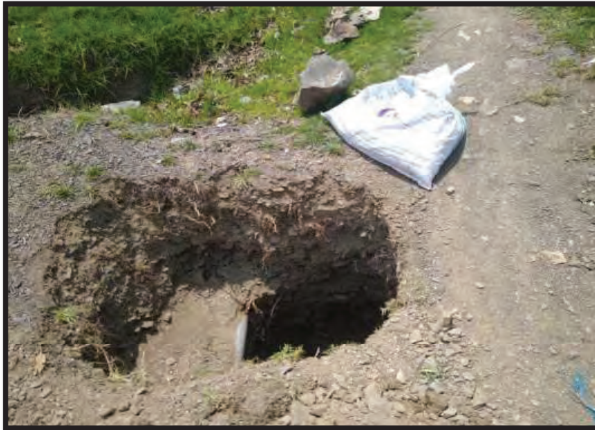
Foto N° 21. Calicata en Reservorio Sachapuna
