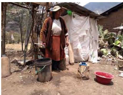
Figura 11. Estado de letrinas existentes
