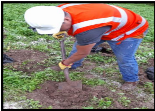
Figura 3: Excavado de hueco
