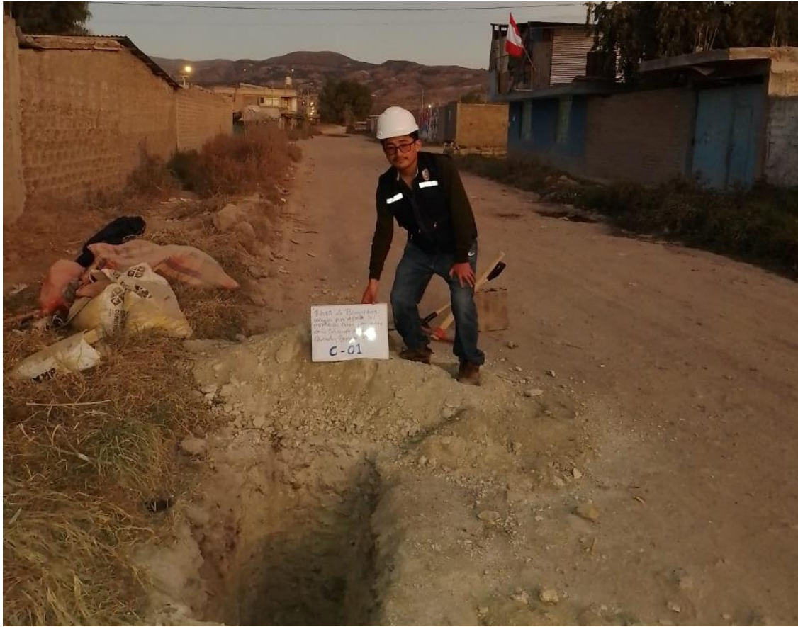
Fotografía N°01: Excavación y extracción de muestra de calicata N°1 (PROG 1+750km)
