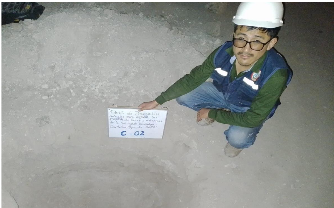
Fotografía N°02: Excavación y extracción de muestra de calicata N°1 (PROG 3+250km)
