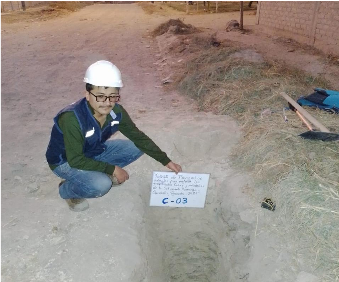
Fotografía N°03: Excavación y extracción de muestra de calicata N°1 (PROG 4+500km)
