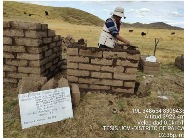
Figura 13. Construcción de los módulos de adobe
