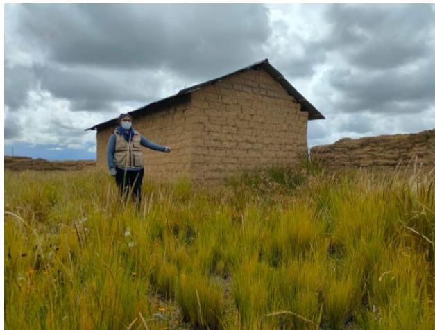
Figura 1. Viviendas construidas con adobe en el distrito de Palca Fuente. Elaboración propia
