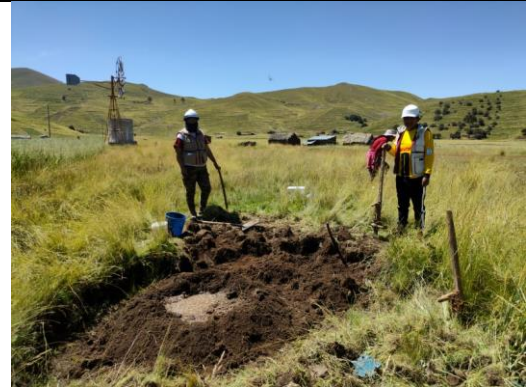
Fotografía 4. Mezcla para la elaboración de adobes
