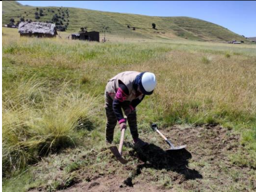
Fotografía 3. Excavación de la calicata
