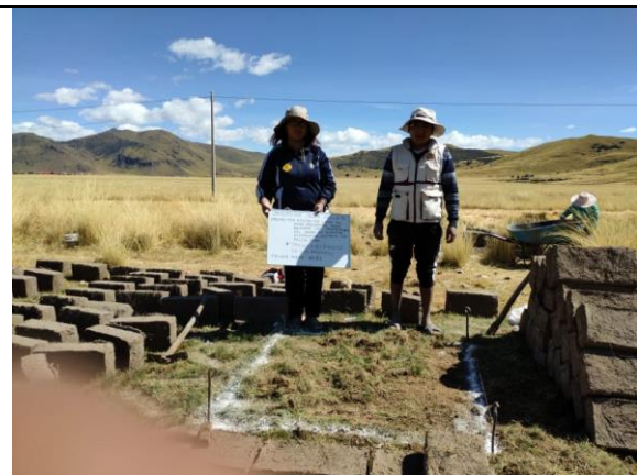
Fotografía 24. Construcción de los módulos de adobe
