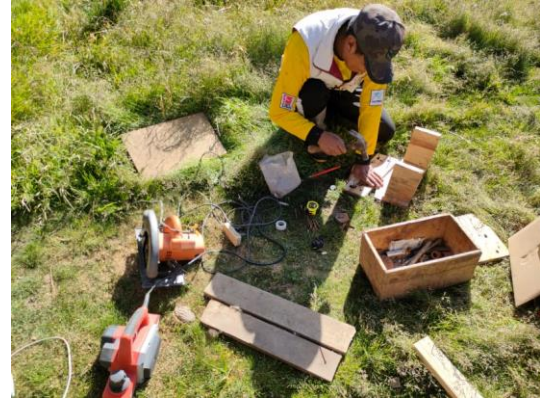
Fotografía 2. Fabricación del molde de adobe
