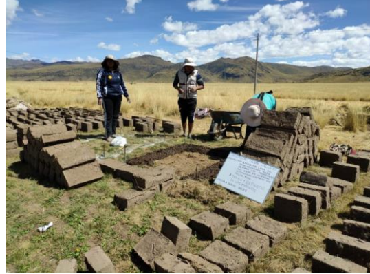
Fotografía 14. Elaboración de adobes
