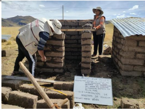
Fotografía 21. Construcción del módulo de adobe
