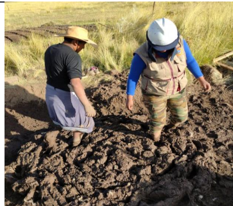
Fotografía 12. Proceso de mezclado para la elaboración de los adobes
