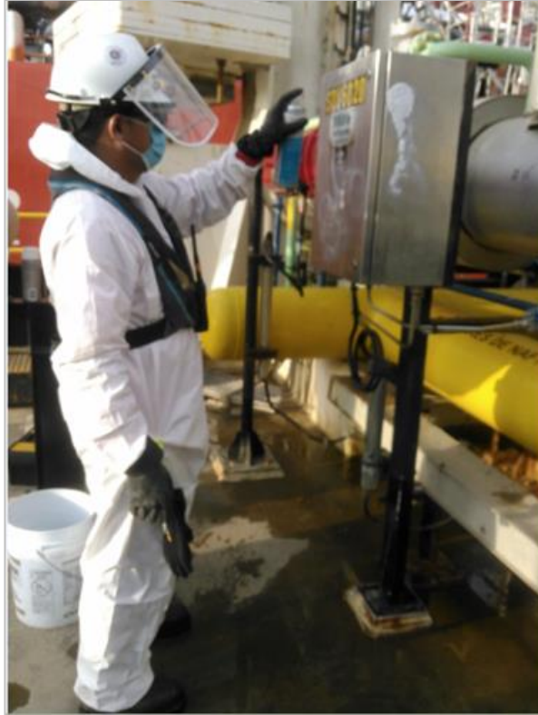
Figura 5. mantenimiento de válvulas shutdown y sistema neumático
