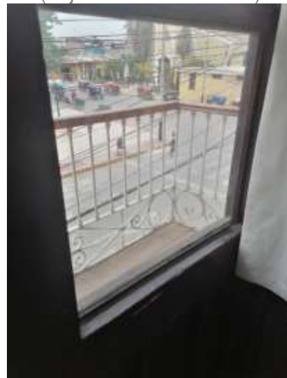
(forjado de los balcones)
