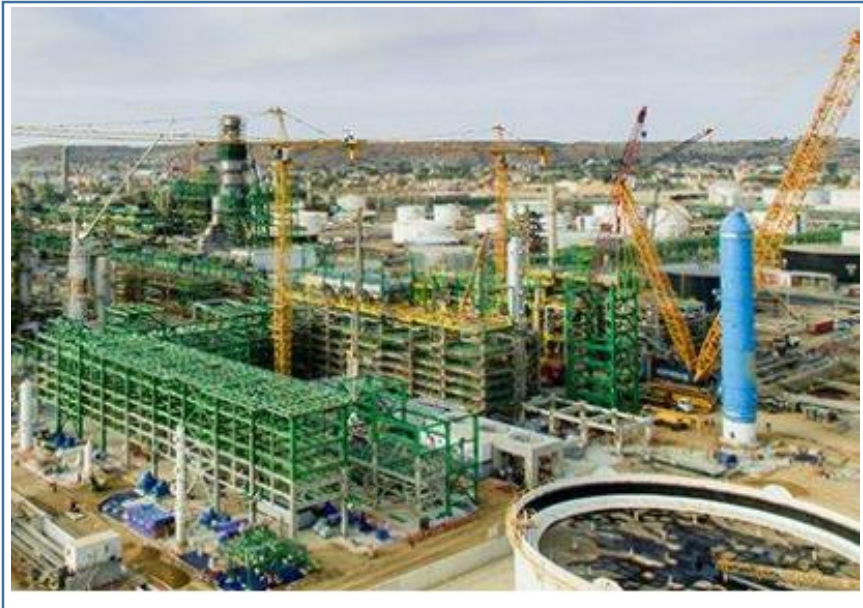
Figura 12. Proyecto Refinería de Talara.
