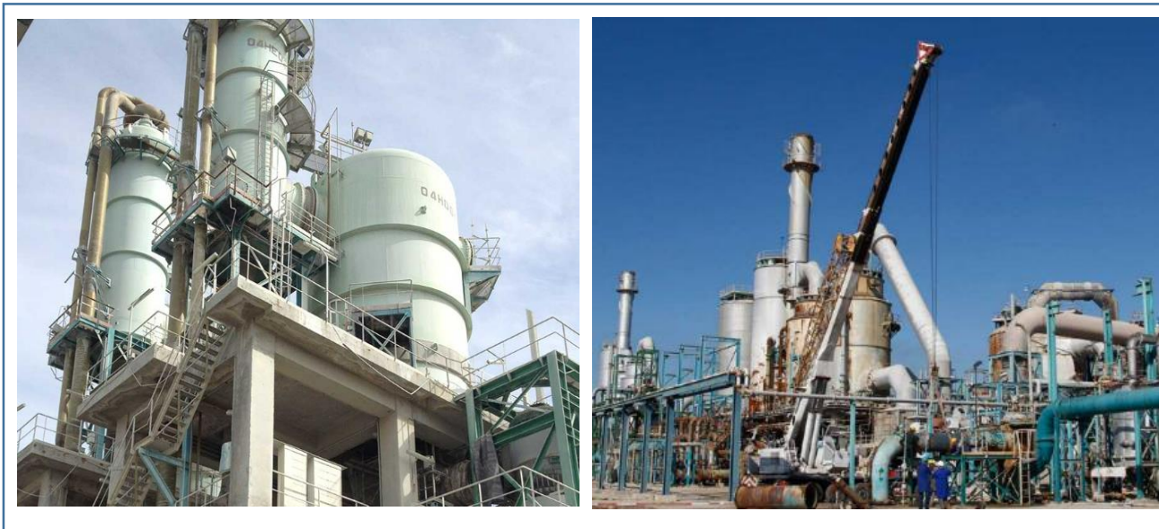
Figura15. montaje de equipos
