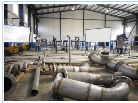
Figura 14. Proceso de Soldeo de tubería
