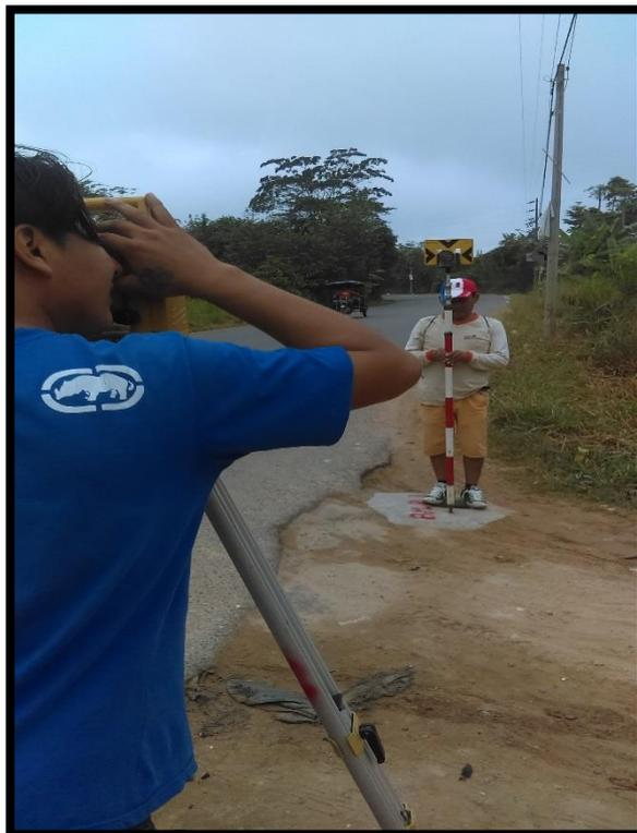
**Fotografía N° 06: Nivelación del Prisma**
