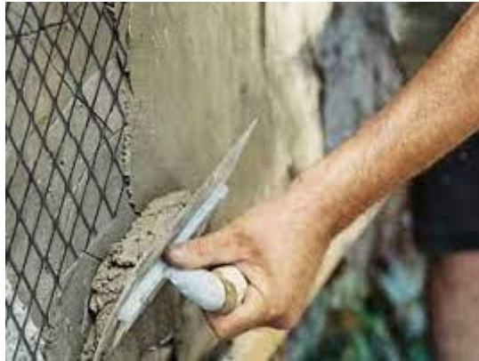
Figura 1. Adherencia de la malla desplegada con mortero de tarrajeo
