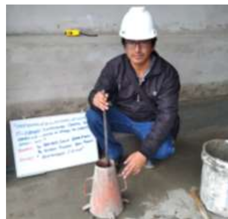
Imagen 20: Prueba de Slump.
