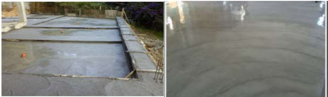
Figura 30. Fotos de la exudación
