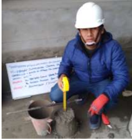
Imagen 21: Medida del asentamiento del concreto.
