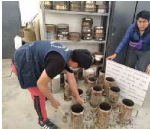
Imagen 23: Realización de las probetas de concreto.
