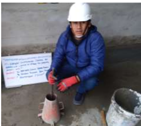
Imagen 19: Prueba de Slump.
