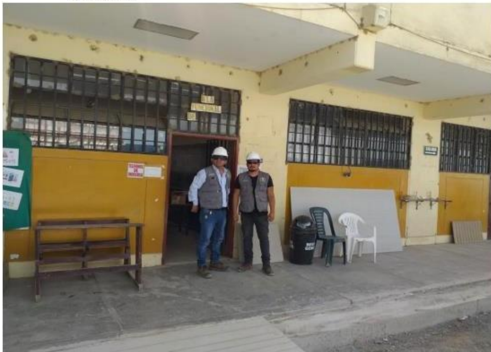
Se verifico el uso correcto de EPP en la obra.
