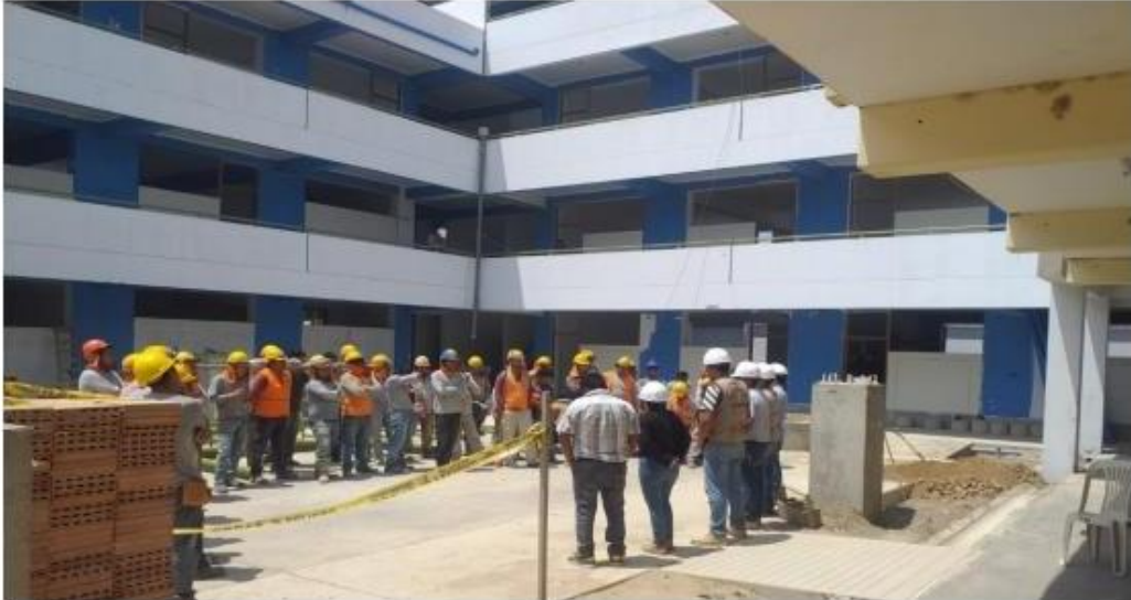
Ingeniero de seguridad inspeccionando las charlas dictadas en obra.
