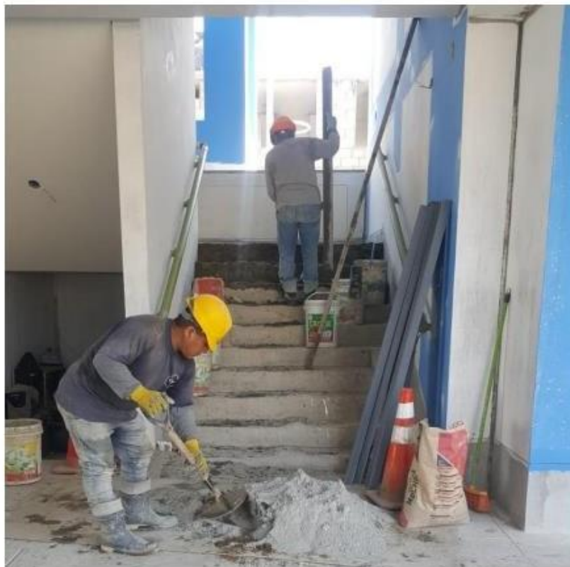
Se verifico el correcto uso de los epp al momento de realizar trabajos en el Pabellón “B”.
