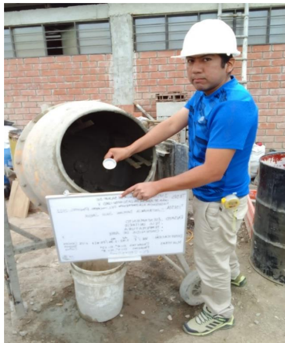
Toma de temperatura de la mezcla de concreto
