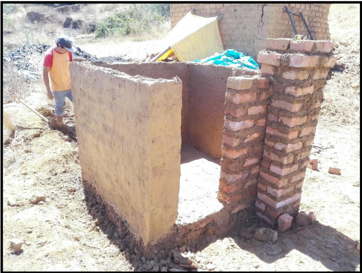
**Fotografía N° 06:** Se observa el proceso de revestimiento de muros y el piso terminado, así mismo, se muestra la chimenea por donde saldrá el aire caliente.
