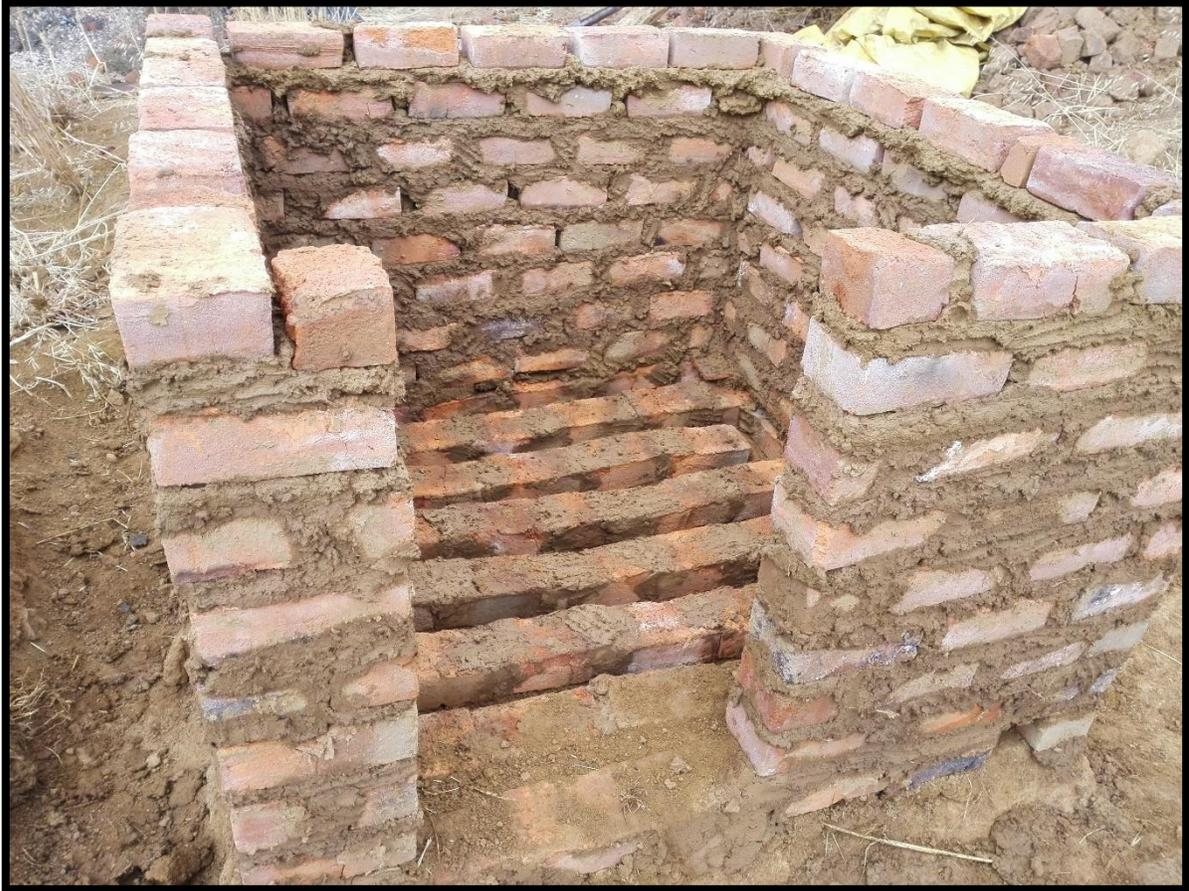
**Fotografía N° 04:** Se observan las canaletas hechas de ladrillo artesanal selladas con mortero de tierra arcillosa; además, se visualiza que los muros perimétricos se ha construido satisfactoriamente.
