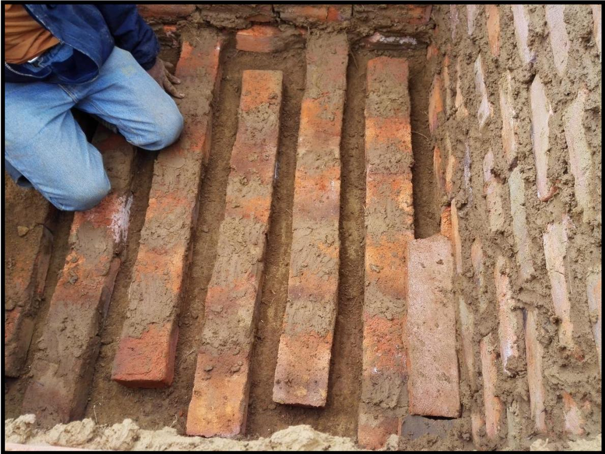
**Fotografía N° 05:** Se observan las canaletas hechas de ladrillo artesanal selladas con mortero de tierra arcillosa; además, se visualiza la colocación de tejas, las cuales permitirán colocar encima la primera capa de mortero de tierra arcillosa para evitar la filtración del humo.
