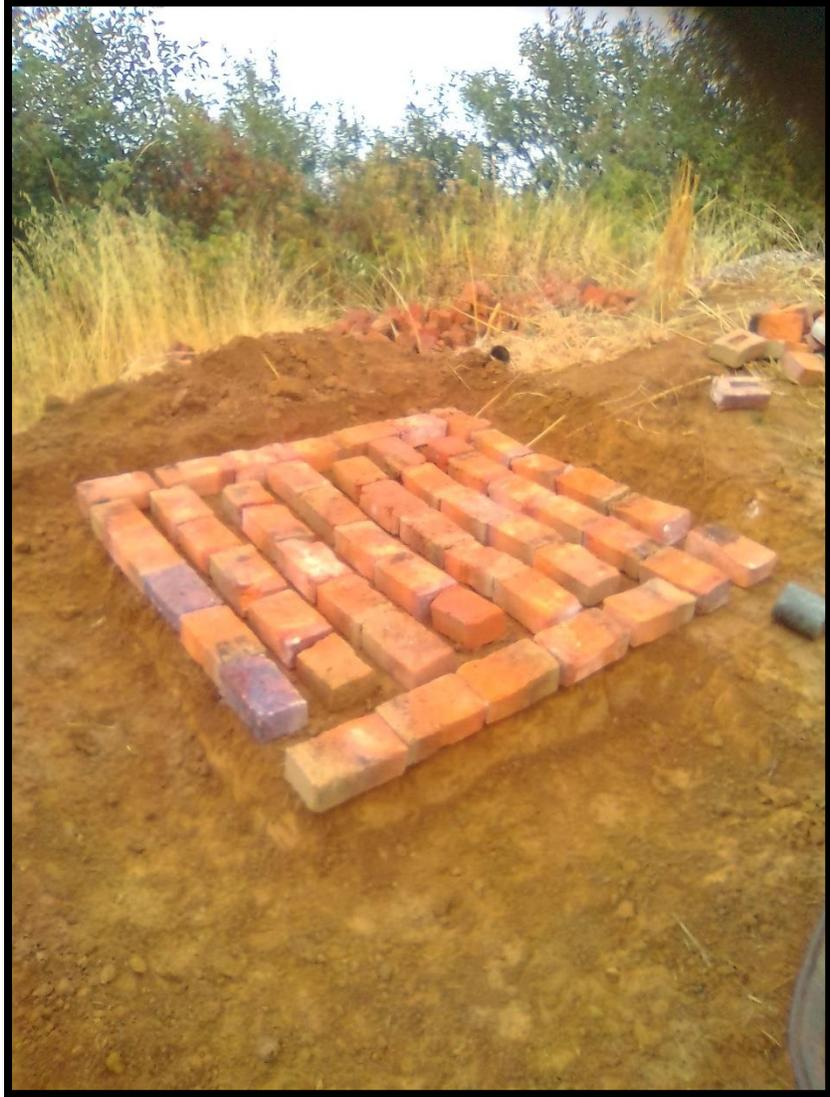
**Fotografía N° 02:** Se observa el asentado del ladrillo para el sistema de calefacción ondol, el tipo de distribución se detalla en los planos.
