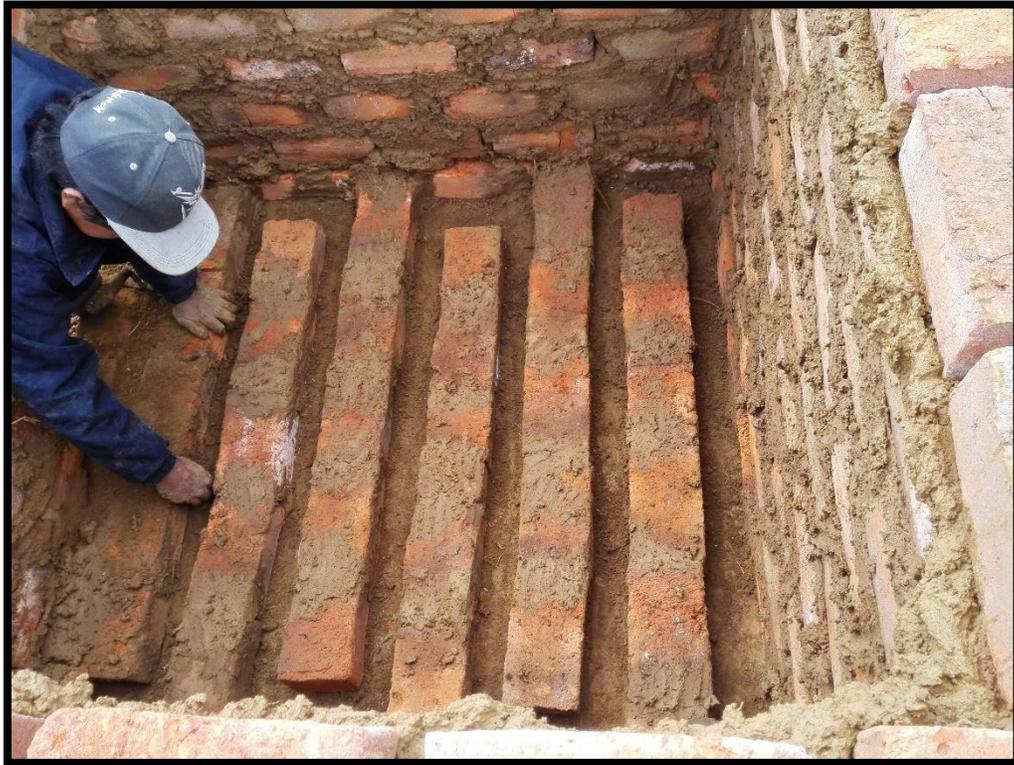
**Fotografía N° 03:** Se observa el sellado, con mortero de tierra arcillosa, de las canaletas por donde pasará el aire caliente, el mismo que da inicio en la cocina, pasa por la habitación contigua donde se encuentra el sistema de ductos y termina en la chimenea.
