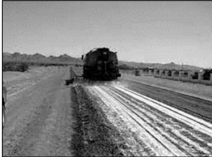
Figura 3. Estabilización de suelos
