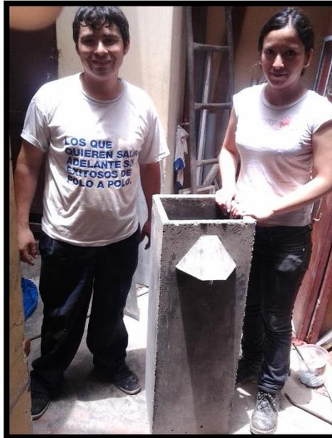
*Figura 12. Desencofrado del Filtro Bioarena.*
