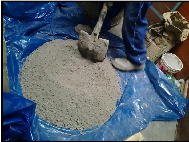
*Figura 9.* Mezcla de piedra chancada de  $\frac{1}{2}$ " (20L), cemento (10Litros) yHormigón cernido (20L).
