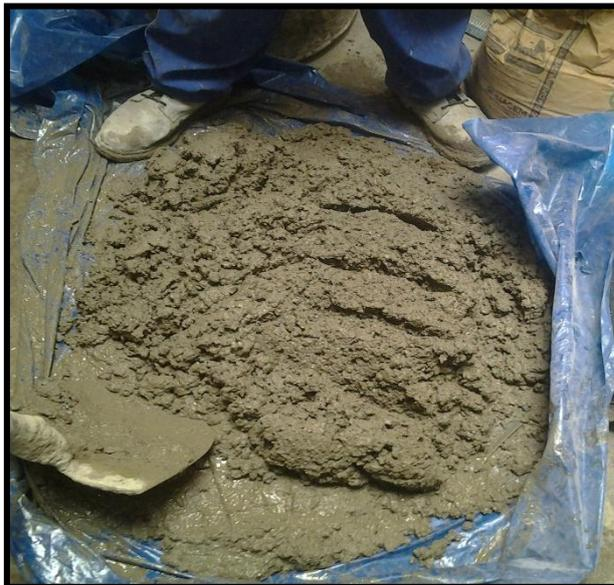
*Figura 10.* Consistencia del hormigón apropiado (Uso 10 Litros de agua).
