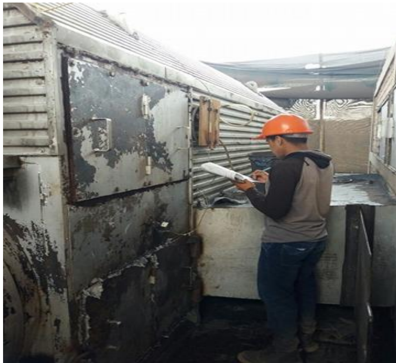
Registro de presión de entrada sala de mezcla
