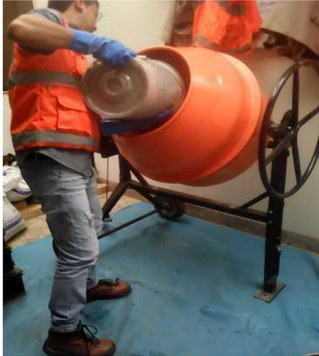
*Figura 25. Incorporación del agregado grueso*
