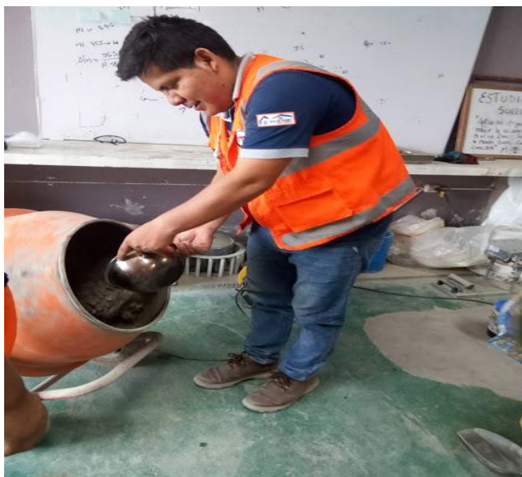
Figura 19: Mezcla del concreto con aditivo sika retarder pe Fuente: propia elaboración
