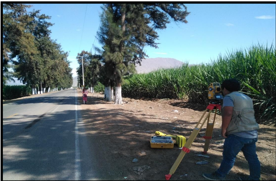
Ilustración N°02: Levantamiento topográfico del tramo en diferentes puntos.
