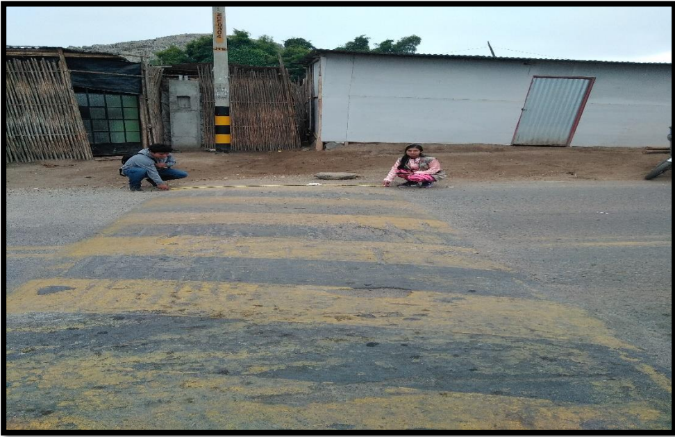
Ilustración N°37: Medición del rompemuella a la señalización 2.50m.
