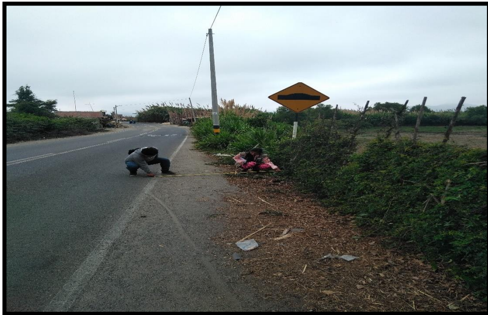
Ilustración N°38: Se constata la señalización de proximidad reductor de velocidad en el Km 1+200.
