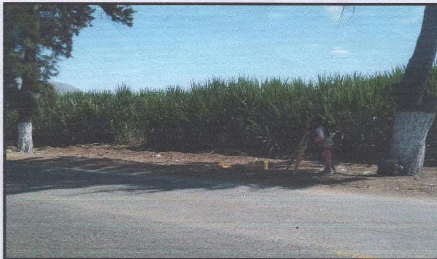
VISTA 03.- En estas vistas se aprecia el levantamiento topográfico del tramo en diferentes puntos.
