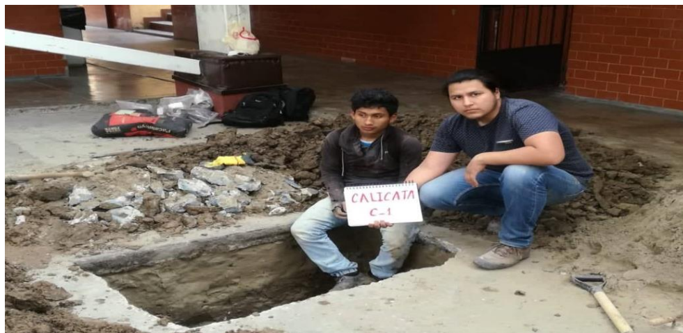
Figura N° 7: I.E. N°10828 “Ex -Cosome”, Excavación de la calicata N°01, 2018.
