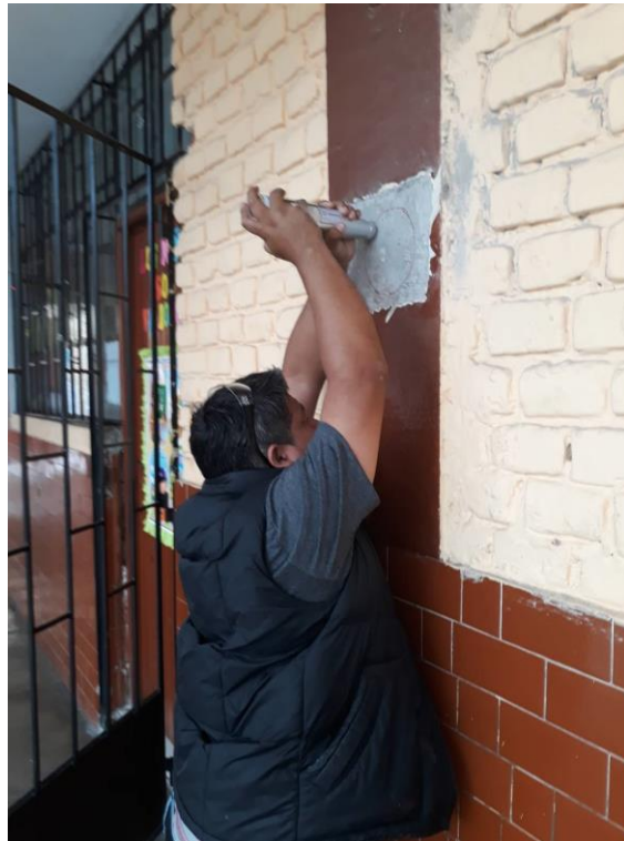
Figura N° 48 : Ensayo de Esclerometría en una Columna
