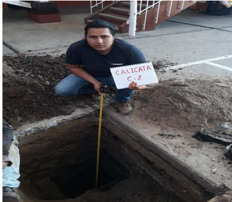
Figura N° 9: I.E. N°10828 “Ex -Cosome”, Excavación de la calicata N°02, 2018.
