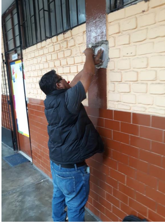
Figura N° 47 : Delimitación en forma de círculo de una columna
