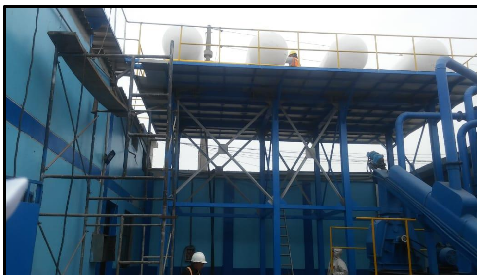
Figura 6. Construcción de plataforma para tanques
