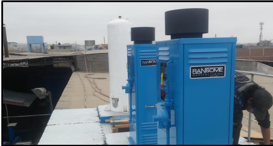
Figura 7. Construcción de plataforma para vaporizadores
