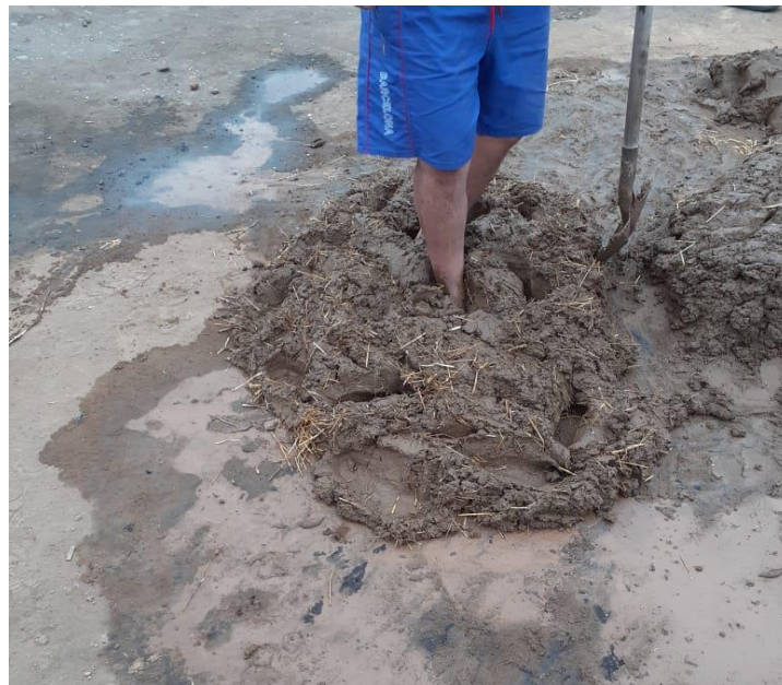
FIGURA 15: Preparación del barro con la paja de trigo
