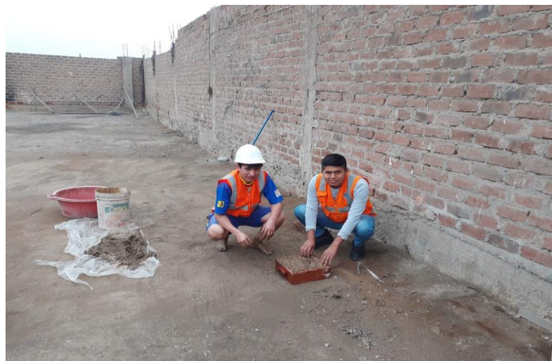
FIGURA 53: Fabricación de las unidades de adobe
