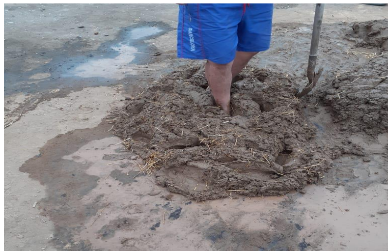
FIGURA 56: Fabricación de las unidades de adobe
