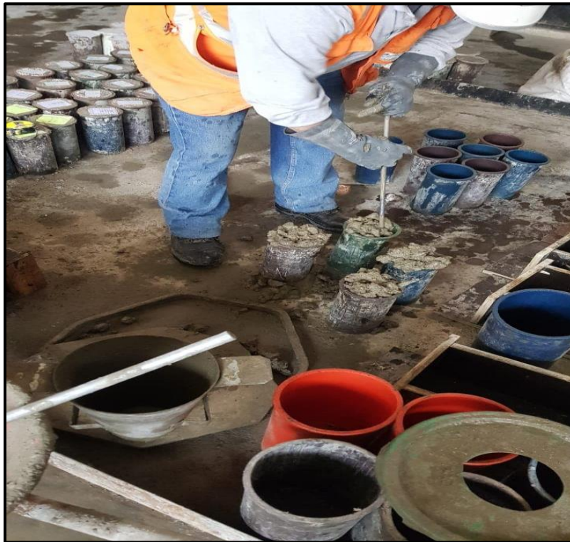
Anexo 20. Compactado del concreto en probetas
