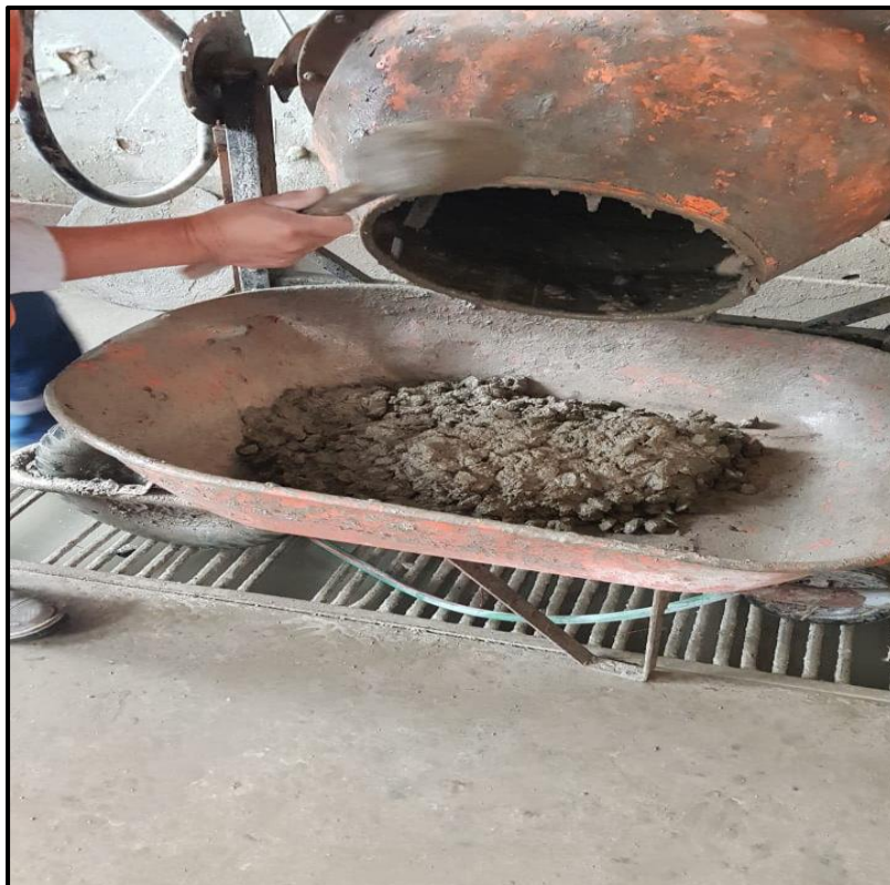
Anexo 19. Preparación de la mezcla para el concreto patrón
