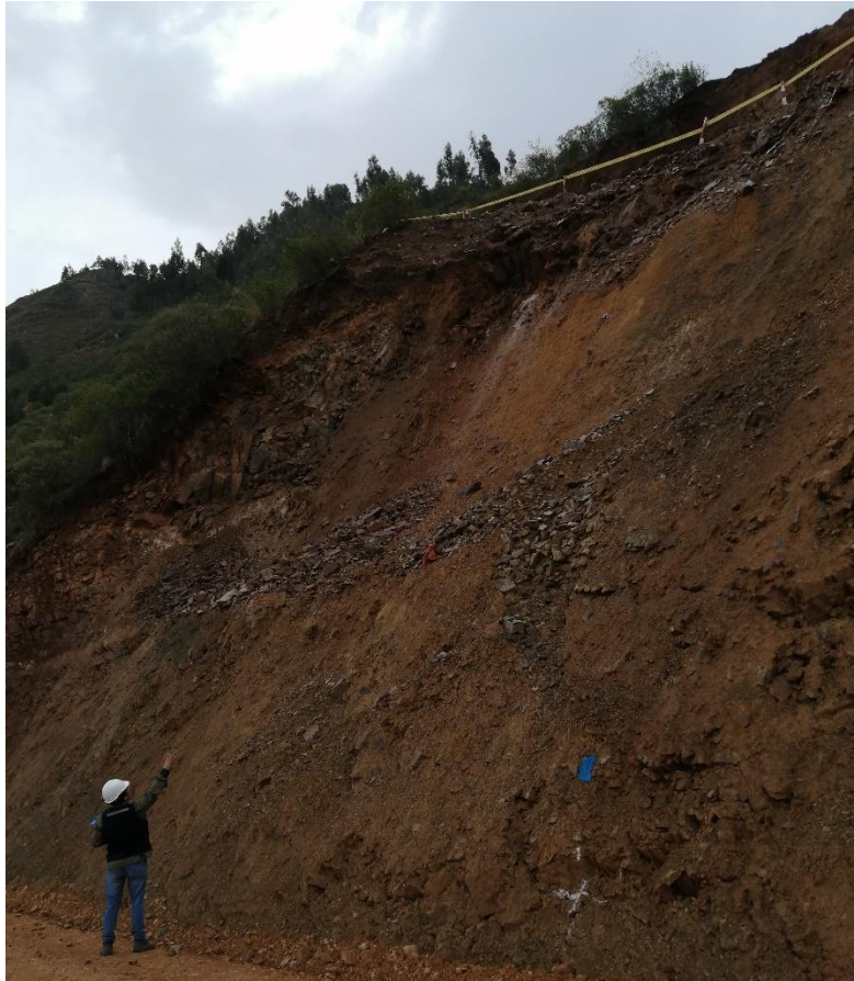
Figura 56. Vista del tramo 2: km 08+360 - km 08+410 Fuente: Elaboración propia
