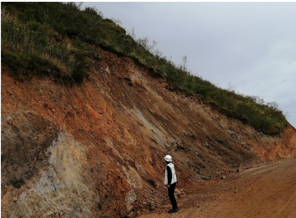
Figura 59. Vista del tramo 5: km 09+235 - km 09+285 Fuente: Elaboración propia
