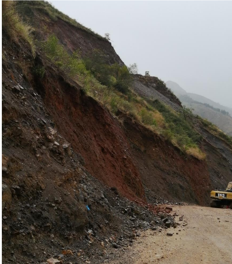
Figura 58. Vista del tramo 4: km 08+900 - km 08+935 Fuente: Elaboración propia
