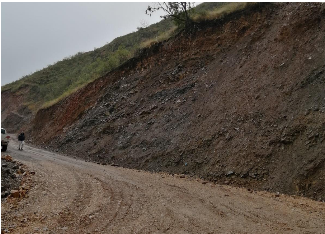
Figura 61. Vista del tramo 7: km 09+750 - km 09+835
