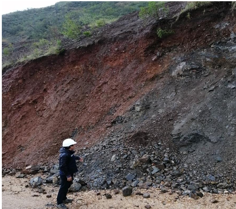
Figura 55. Vista del tramo 1: km 08+170 - km 08+220 Fuente: Elaboración propia
