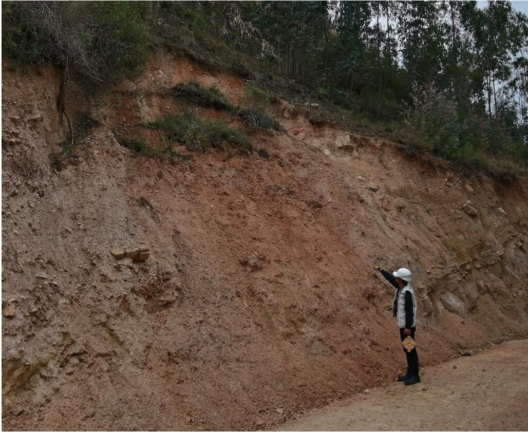
Figura 60. Vista del tramo 6: km 09+580 - km 09+630
