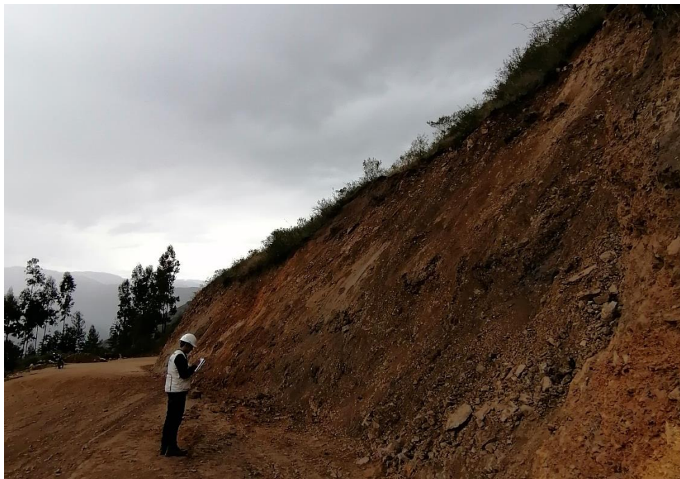
Figura 57. Vista del tramo 3: km 08+645 - km 08+680 Fuente: Elaboración propia
