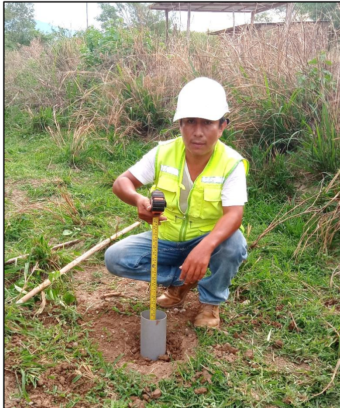
Figura 45. Colocación del tubo de 4" para ensayo de permeabilidad
