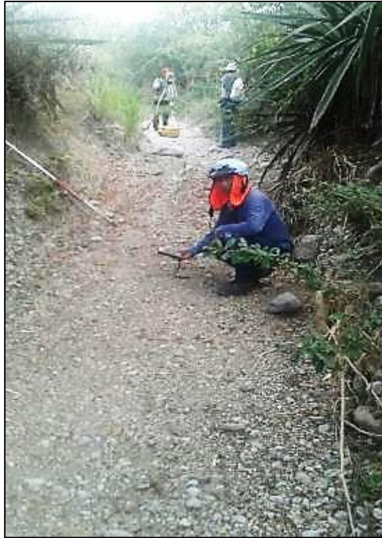
Figura 41. Levantamiento topográfico quebrada La Caballa
