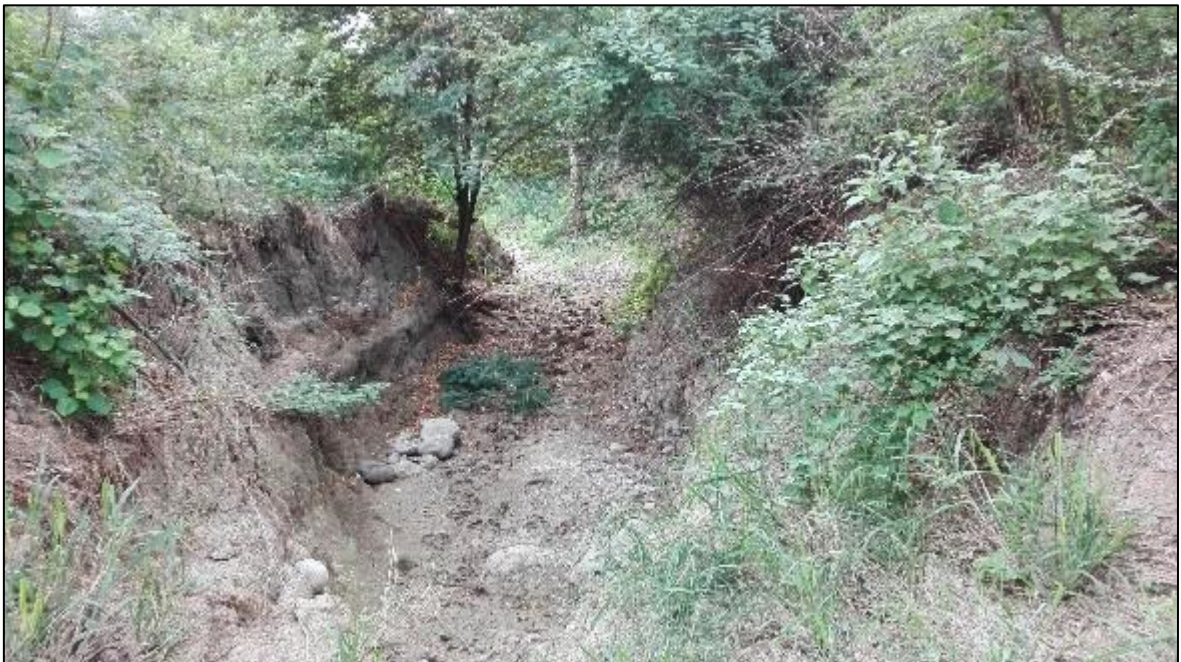
Figura 44. Vista sección transversal quebrada La Caballa
