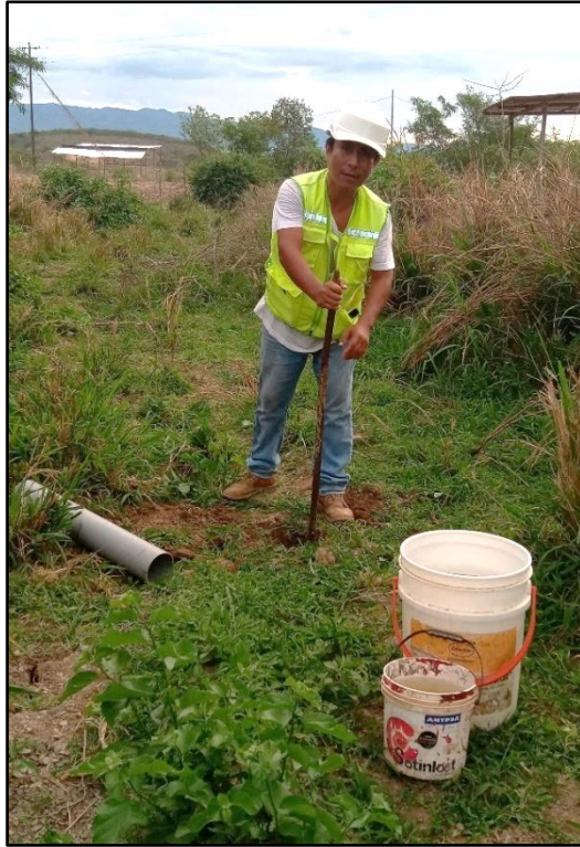
Figura 46. Excavación del hoyo para ensayo de permeabilidad
