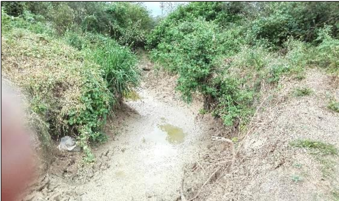
Figura 36. Aguas residuales de las fuertes lluvias
