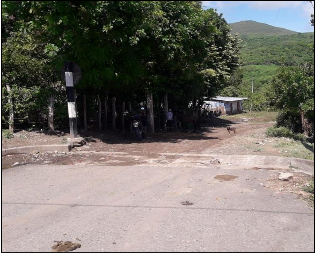
TOMA N° 01: VISTA PANORÁMICA DEL KM=0+000.00 INICIO DEL PROYECTO
