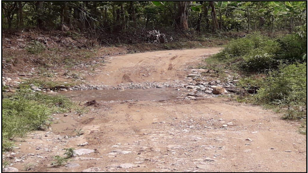
TOMA N° 02: PASE DE AGUA KM 1+500, ALC TIPO TMC.
