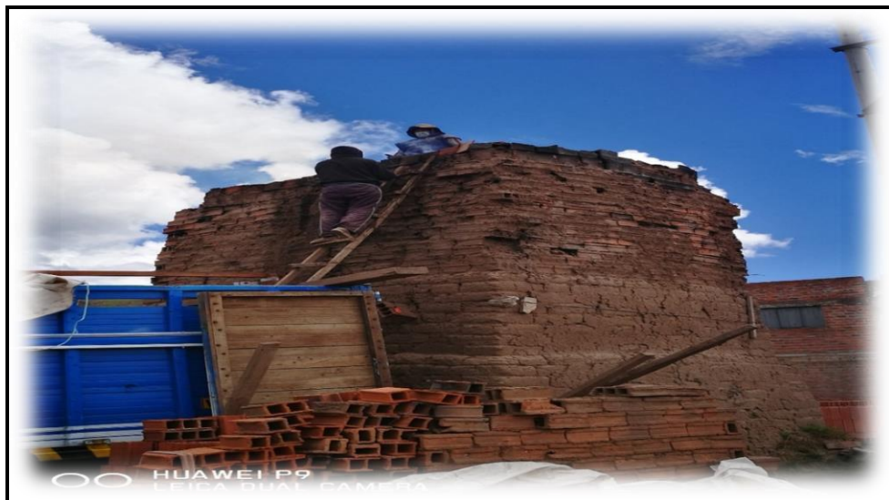
Figura 11 Realizando el horneado de los ladrillos
