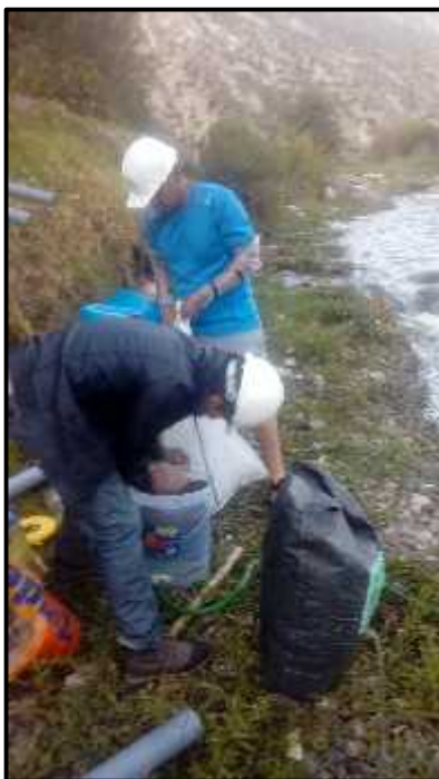
Foto de colocación de arena gruesa Fuente: Elaboración propia.
