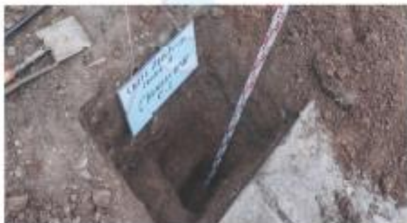
FOTO N°69: VISTA A CIELO ABIERTO DE LOS ESTRATOS DE LA CALZADA.
