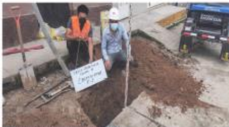
FOTO N°68: VISTA A CIELO ABIERTO DE LA CALZADA.
