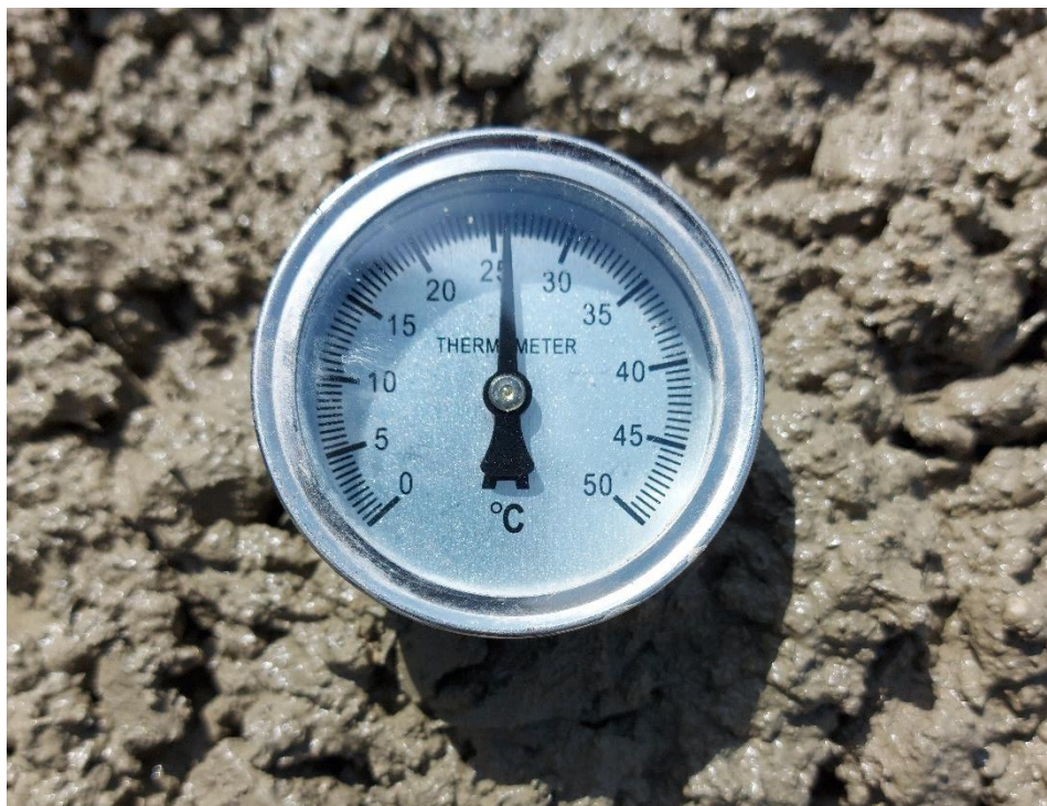
Control de temperatura de concreto
