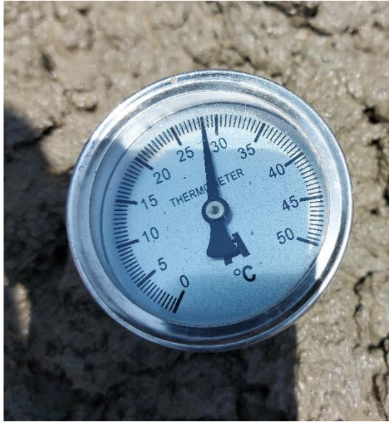
Control de temperatura del concreto
