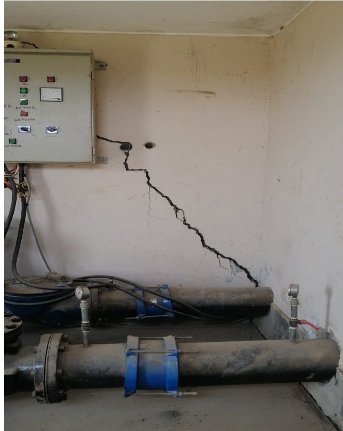
Figura 27. Muros agrietados
